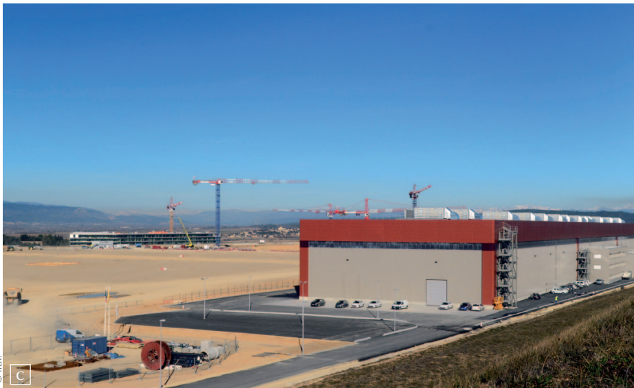
6. Quatre photos prises sur le site d'ITER en 2012. Les vues (a) et (b) montrent les fondations du hall tore équipées du système d'isolation sismique. Les vues (c) et (d) montrent le grand hall qui servira à construire sur place les grandes bobines de champ poloïdal. Le bâtiment qui abrite le siège de l'organisation internationale est visible en arrière-plan sur les vues (a) et (c) ; il a été inauguré le 17 janvier 2013.
