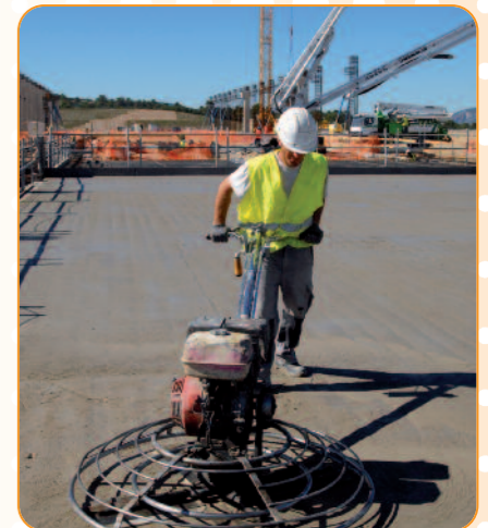
Dalle du bâtiment des bobines poloïdales
