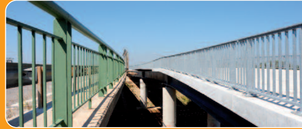
Nouveau pont au-dessus de la voie ferrée entre Berre et La Fare
