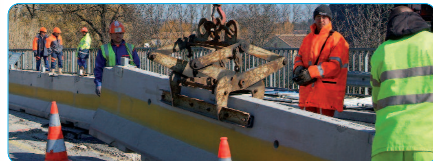
Chantier sur la RD 15
