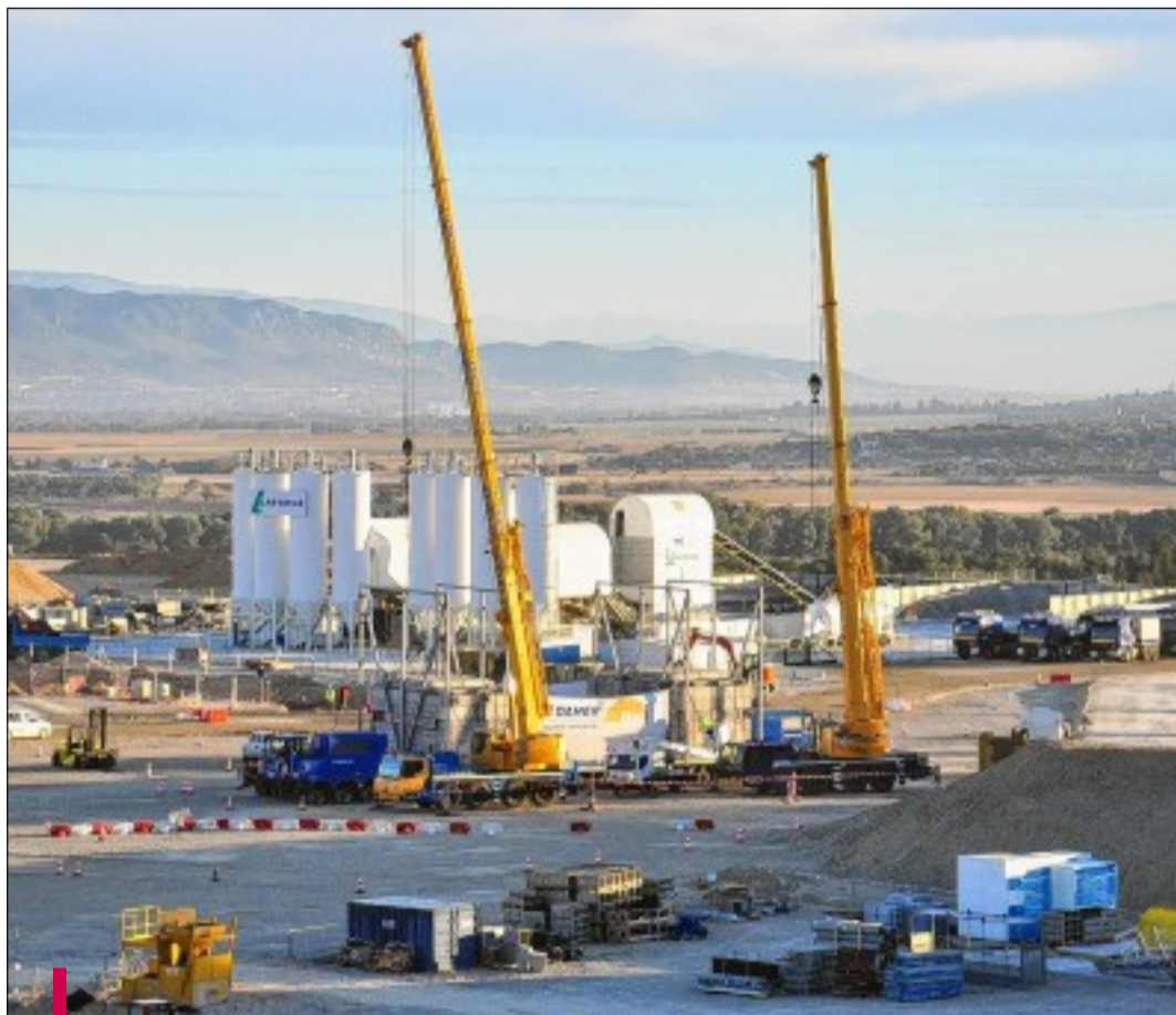
Aux premières lueurs de l'aube, le démontage du convoi débute sur le site d'Iter. Il va durer près de deux jours.
