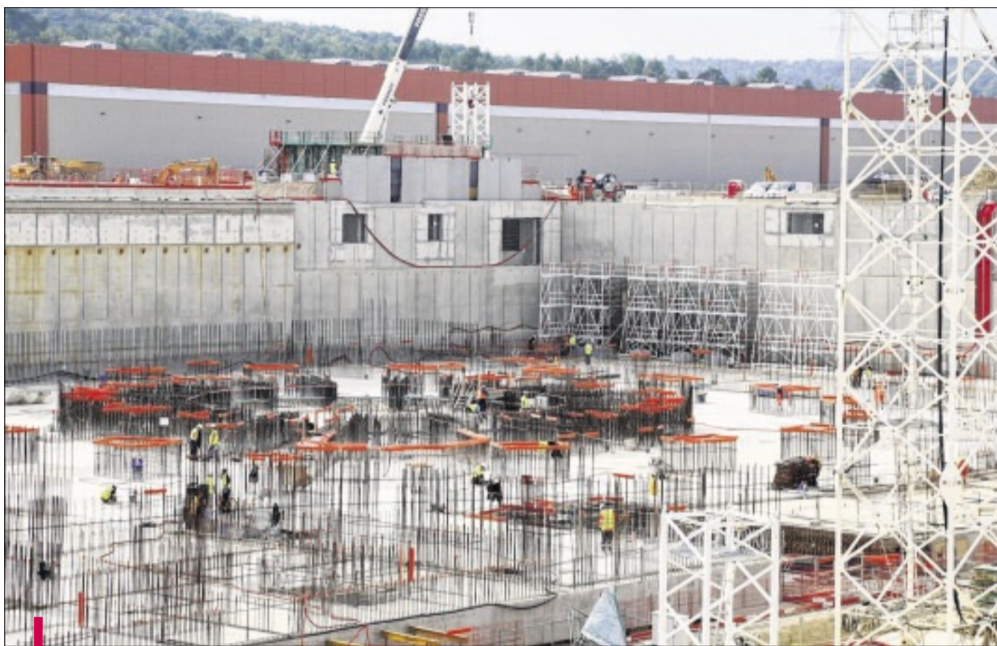
Le chantier bat son plein, avec des ouvriers toujours plus nombreux, comme sur cette dalle qui repose sur 493 plots parasismiques et qui supportera le bâtiment abritant le réacteur.
