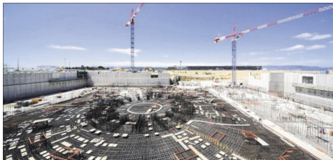
Le chantier du Tokamak avance à grande vitesse. 350 ouvriers travaillent actuellement sur le site.
