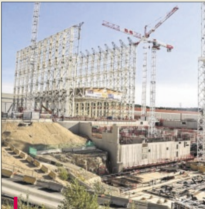
Le bâtiment, dont le toit a été installé dans la nuit, sera directement relié au réacteur "Tokamak". / PHOTOS STÉPHANE DUCLET
