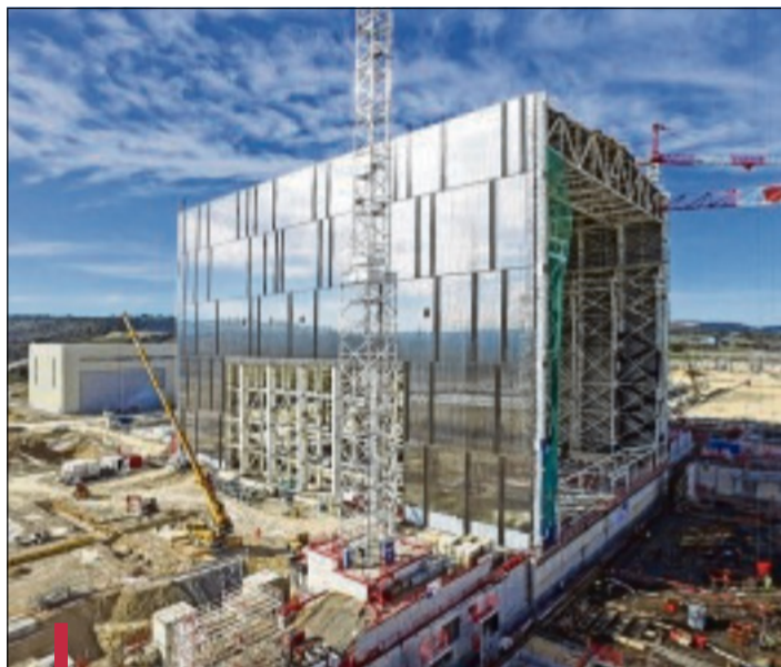
Le bardage de la façade nord du Hall d'assemblage photographié il y a quelques jours sur le site de Cadarache. / PH. ITER ORGANIZATION
