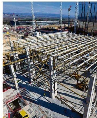
Une vue du chantier de la construction du réacteur expérimental Iter. Devant la façade du bâtiment où sera le tokamak, la réalisation d'une unité de refroidissement / PHOTO ITER ORGANIZATION
