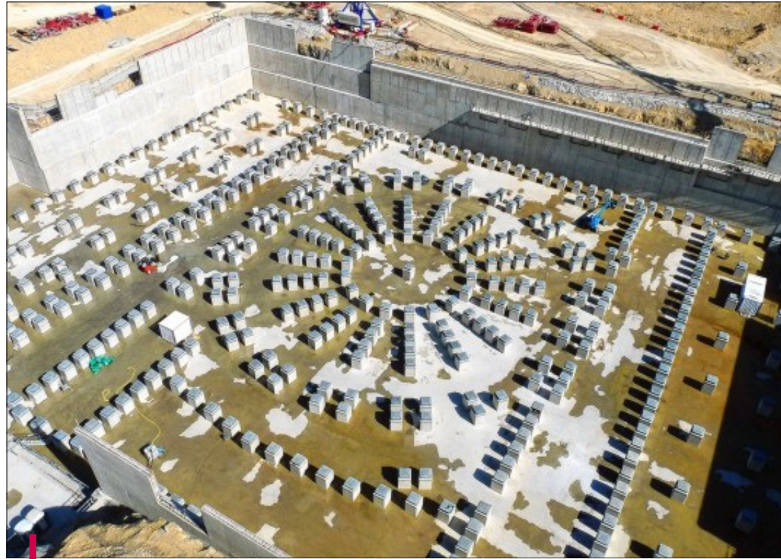
À Cadarache, l'installation parasismique sur laquelle sera installé le tokamak, est terminée.
