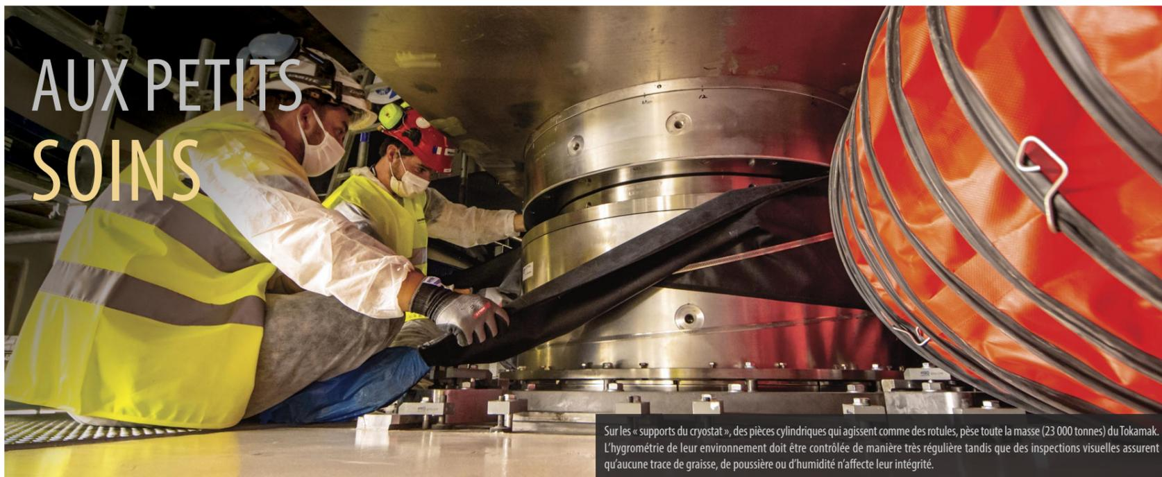
Sur les « supports du cryostat », des pièces cylindriques qui agissent comme des rotules, pèse toute la masse (23 000 tonnes) du Tokamak. L'hygrométrie de leur environnement doit être contrôlée de manière très régulière tandis que des inspections visuelles assurent qu'aucune trace de graisse, de poussière ou d'humidité n'affecte leur intégrité.
