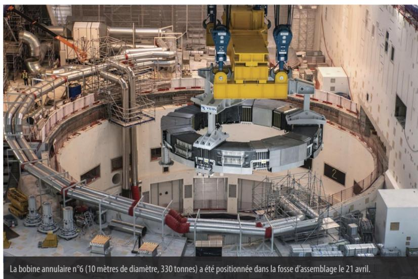
La bobine annulaire n°6 (10 mètres de diamètre, 330 tonnes) a été positionnée dans la fosse d'assemblage le 21 avril.
