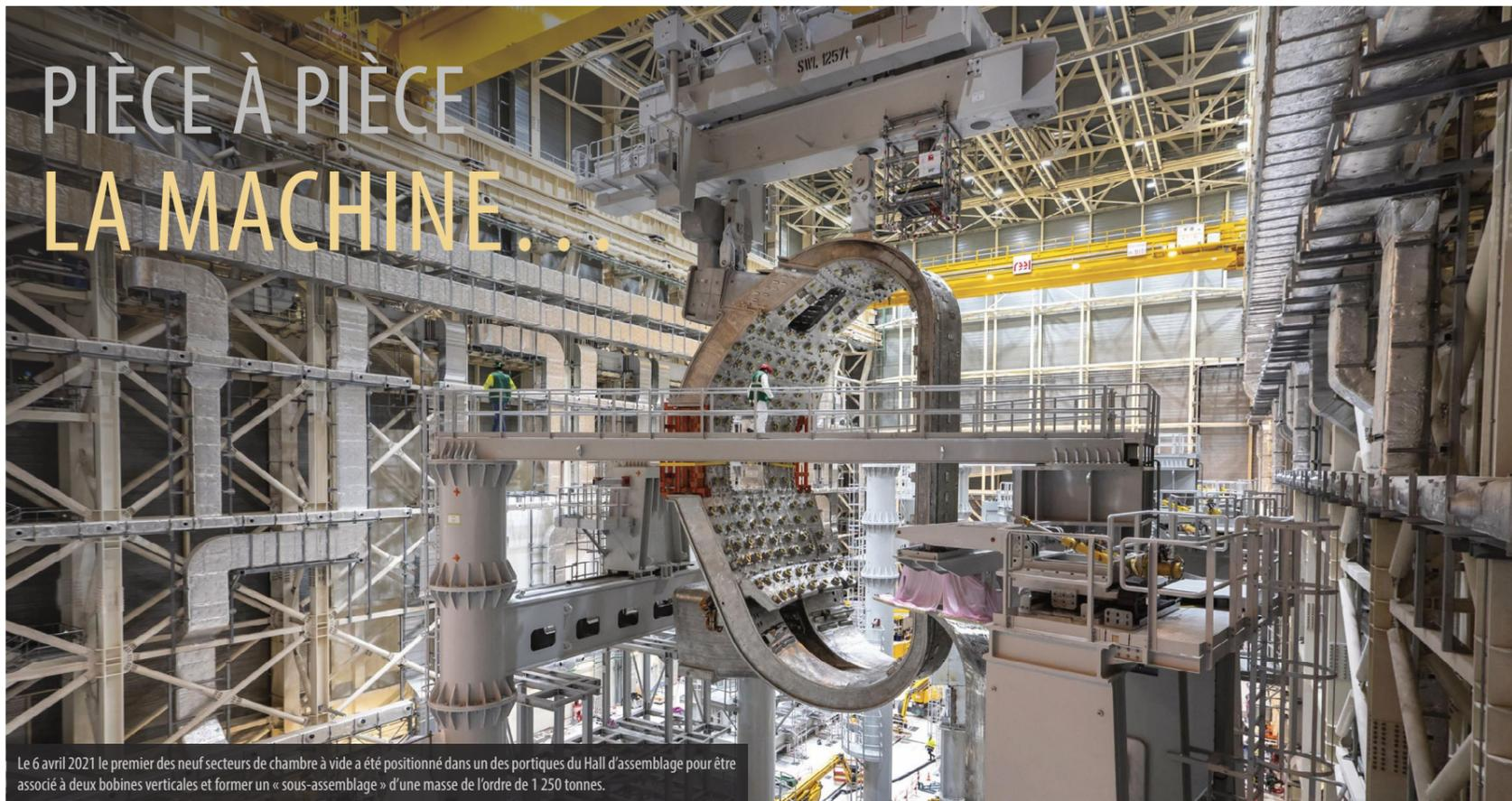
Le 6 avril 2021 le premier des neuf secteurs de chambre à vide a été positionné dans un des portiques du Hall d'assemblage pour être associé à deux bobines verticales et former un « sous-assemblage » d'une masse de l'ordre de 1 250 tonnes.
