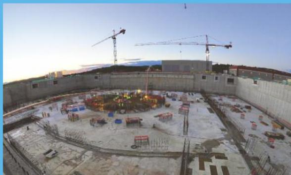
14 000 m<sup>3</sup> de béton, 3 600 tonnes de ferrailage, 8 mois de travail – le « plancher » du Complexe Tokamak a été finalisé le 27 août.
