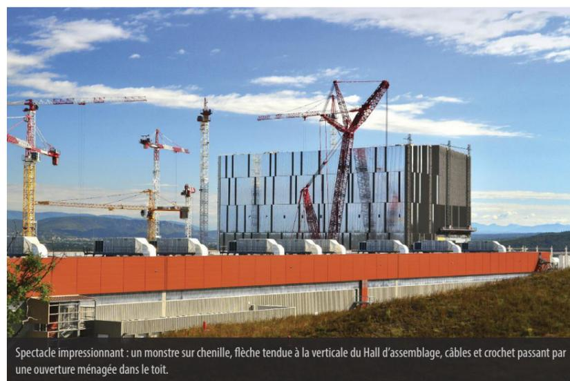
Spectacle impressionnant : un monstre sur chenille, flèche tendue à la verticale du Hall d'assemblage, câbles et crochet passant par une ouverture ménagée dans le toit.
