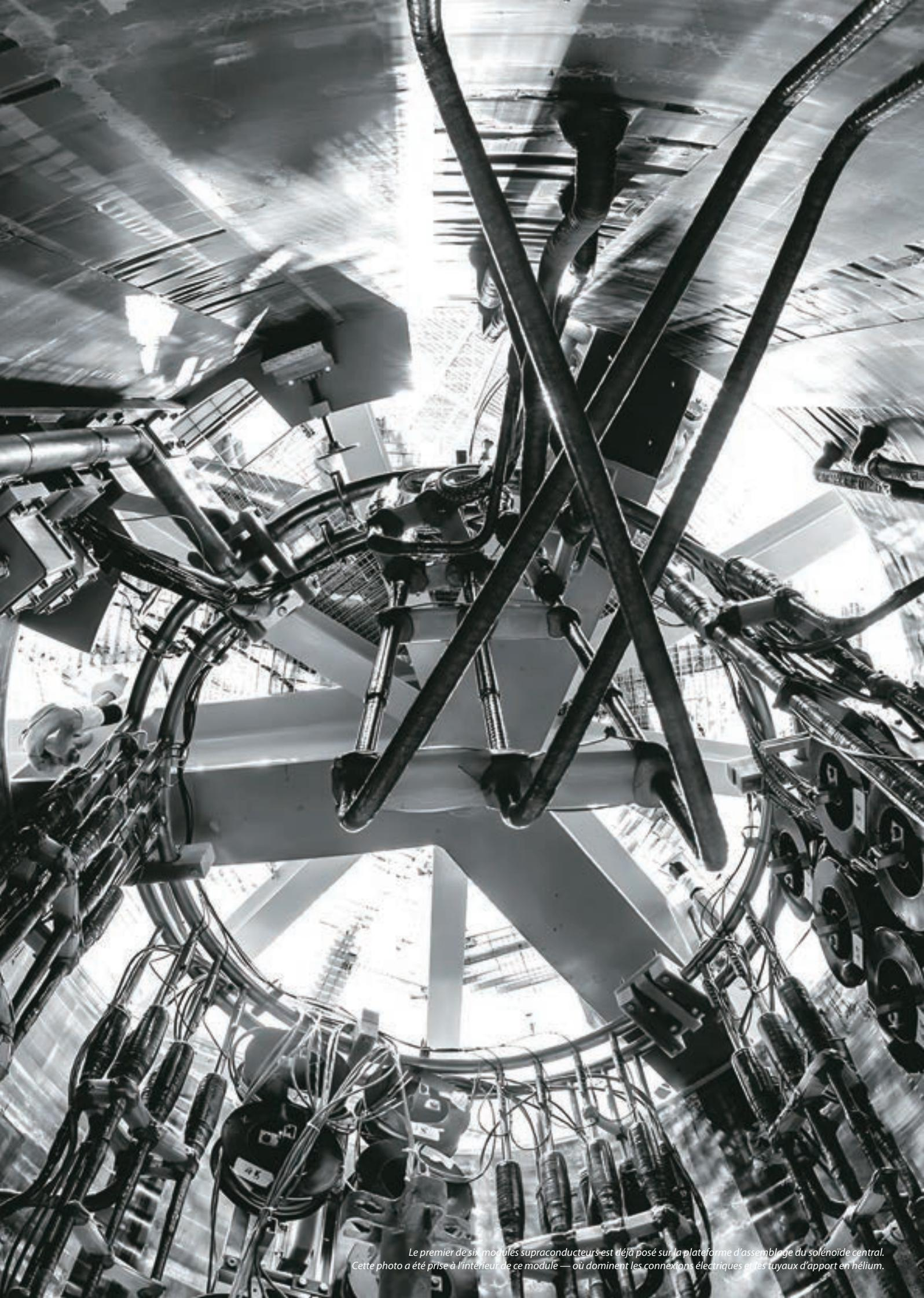
*Le premier de six modules supraconducteurs est déjà posé sur la plateforme d'assemblage du solénoïde central. Cette photo a été prise à l'intérieur de ce module — où dominent les connexions électriques et les tuyaux d'apport en hélium.*
