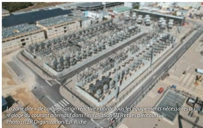
La zone dite « de compensation réactive » abrite tous les équipements nécessaires au réglage du courant alternatif dans l'installation ITER et ses alentours. Photo : ITER Organization/EJF Riche
