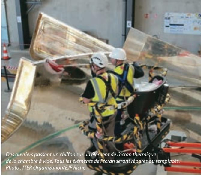
Des ouvriers passent un chiffon sur un élément de l'écran thermique de la chambre à vide. Tous les éléments de l'écran seront réparés ou remplacés.
