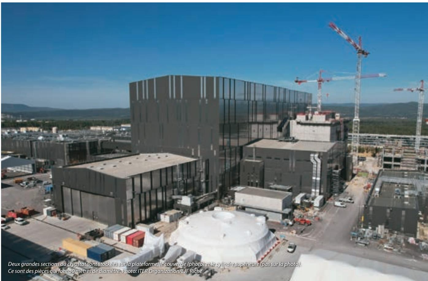
Deux grandes sections du cryostat sont stockées sur la plateforme, le couvercle (photo) et le cylindre supérieure (pas sur la photo). Ce sont des pièces qui font 30 mètres de diamètre. Photo: ITER Organization/EJF Riche
