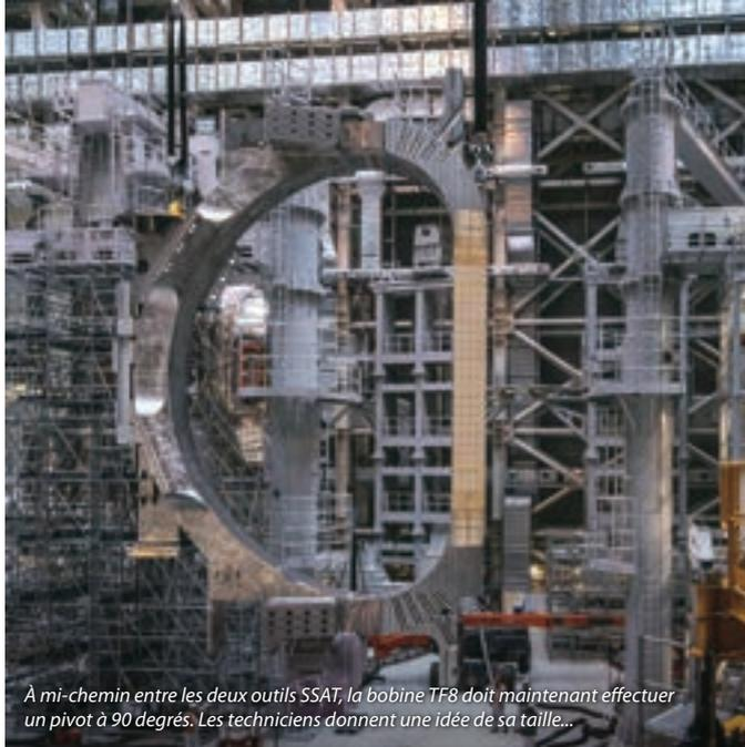
À mi-chemin entre les deux outils SSAT, la bobine TF8 doit maintenant effectuer un pivot à 90 degrés. Les techniciens donnent une idée de sa taille...
