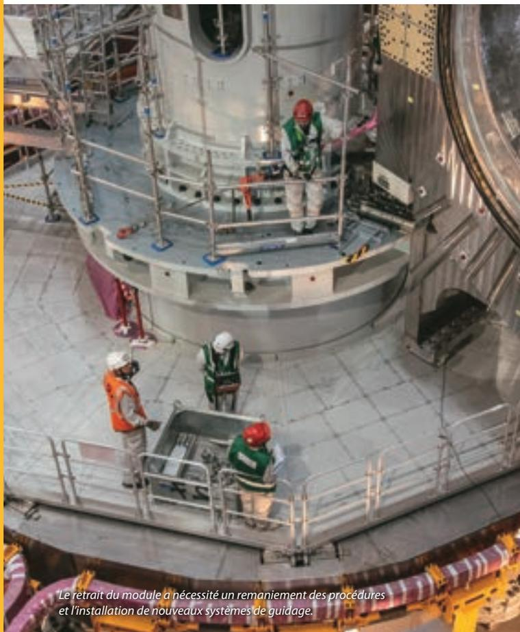
*Le retrait du module a nécessité un remaniement des procédures et l'installation de nouveaux systèmes de guidage.*
