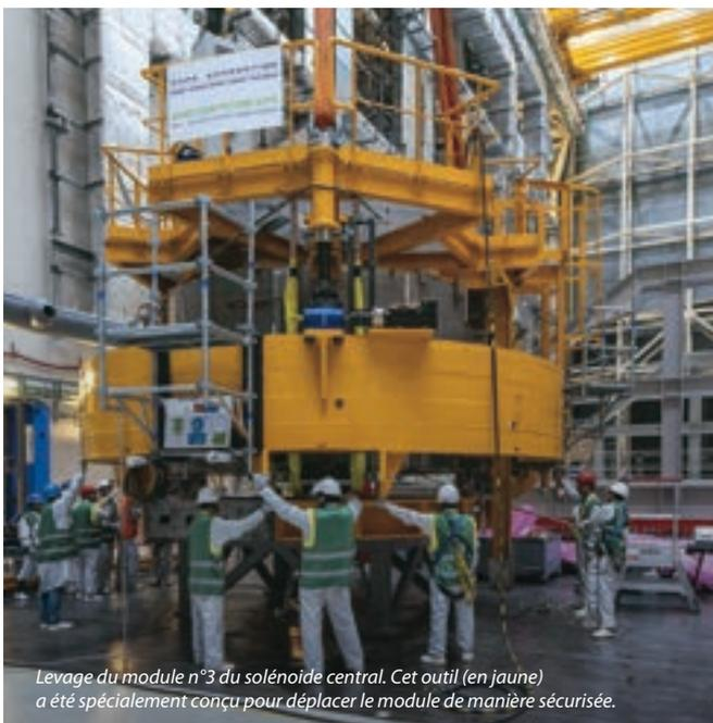
Levage du module n°3 du solénoïde central. Cet outil (en jaune) a été spécialement conçu pour déplacer le module de manière sécurisée.
