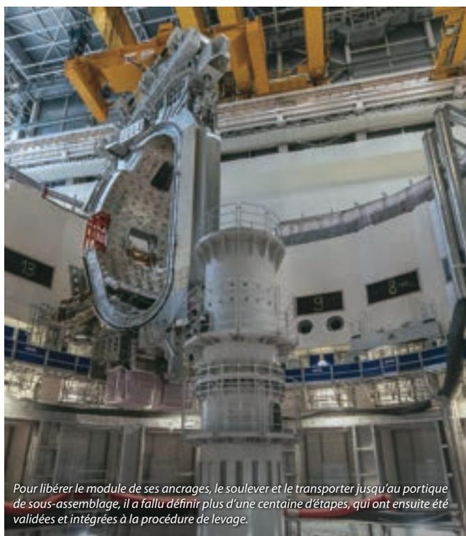
*Pour libérer le module de ses ancrages, le soulever et le transporter jusqu'au portique de sous-assemblage, il a fallu définir plus d'une centaine d'étapes, qui ont ensuite été validées et intégrées à la procédure de levage.*
