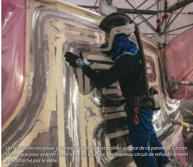
Un technicien en tenue de protection nettoie et polit la surface de ce panneau d'écran thermique pour enlever toute trace de soudure. Un nouveau circuit de refroidissement sera attaché par la suite.
