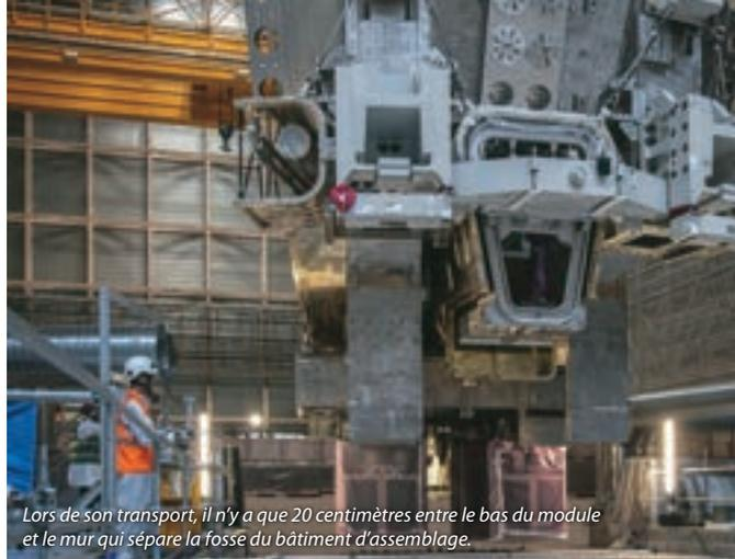
Lors de son transport, il n'y a que 20 centimètres entre le bas du module et le mur qui sépare la fosse du bâtiment d'assemblage.
