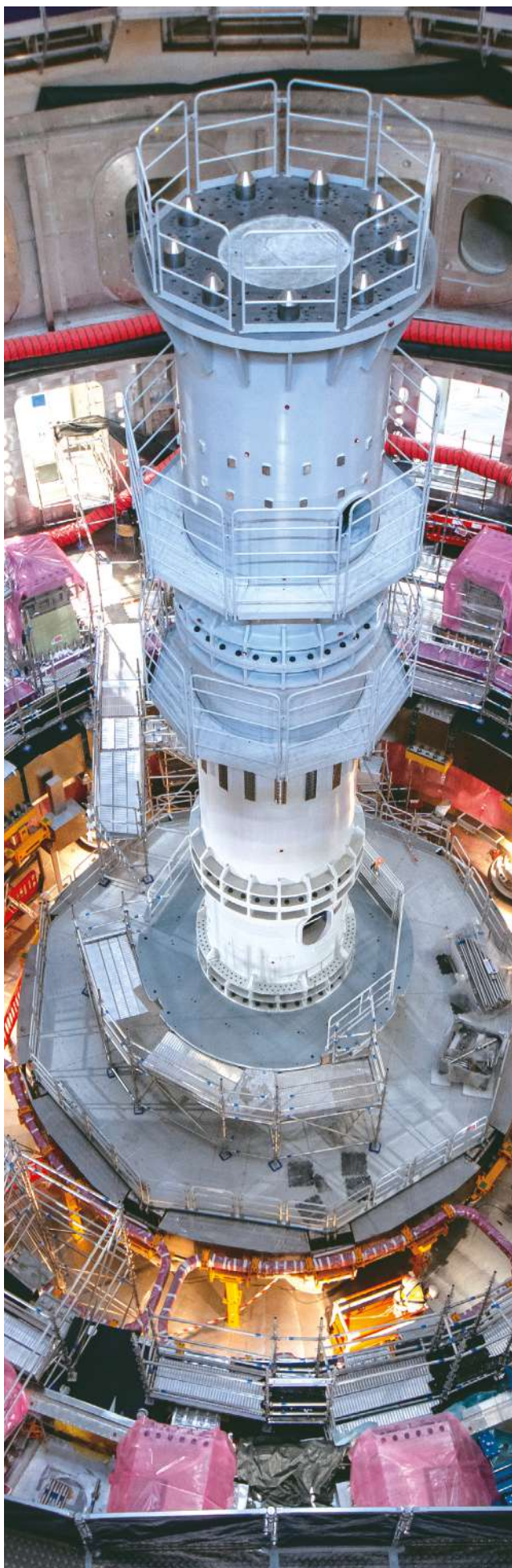
▲ Colonne centrale dans le puits du Tokamak
