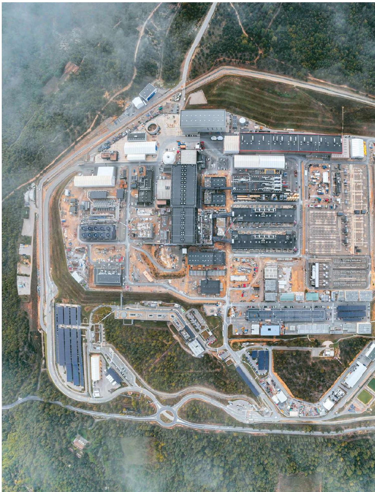
▲ Quatorze années après le lancement des travaux, la quasi-totalité du génie civil est achevée.
