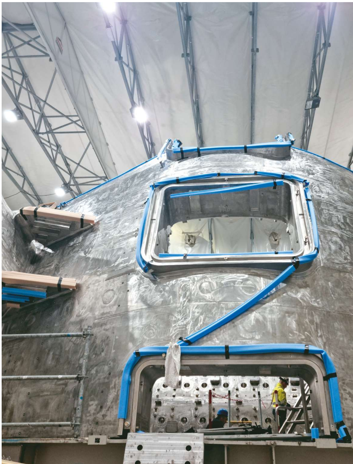
▲ Les tests d'étanchéité ont été réalisés avec succès sur le premier des cinq secteurs de la chambre à vide sous la responsabilité de Fusion for Energy, l'agence domestique européenne pour ITER. ©F4E
