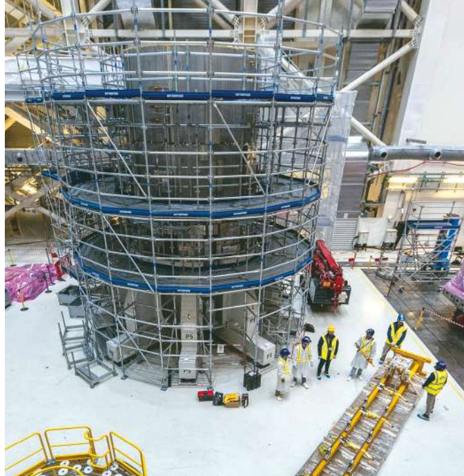
▲ La troisième bobine indépendante du solénoïde central d'ITER a quitté sa plateforme temporaire pour rejoindre la « tour ».
