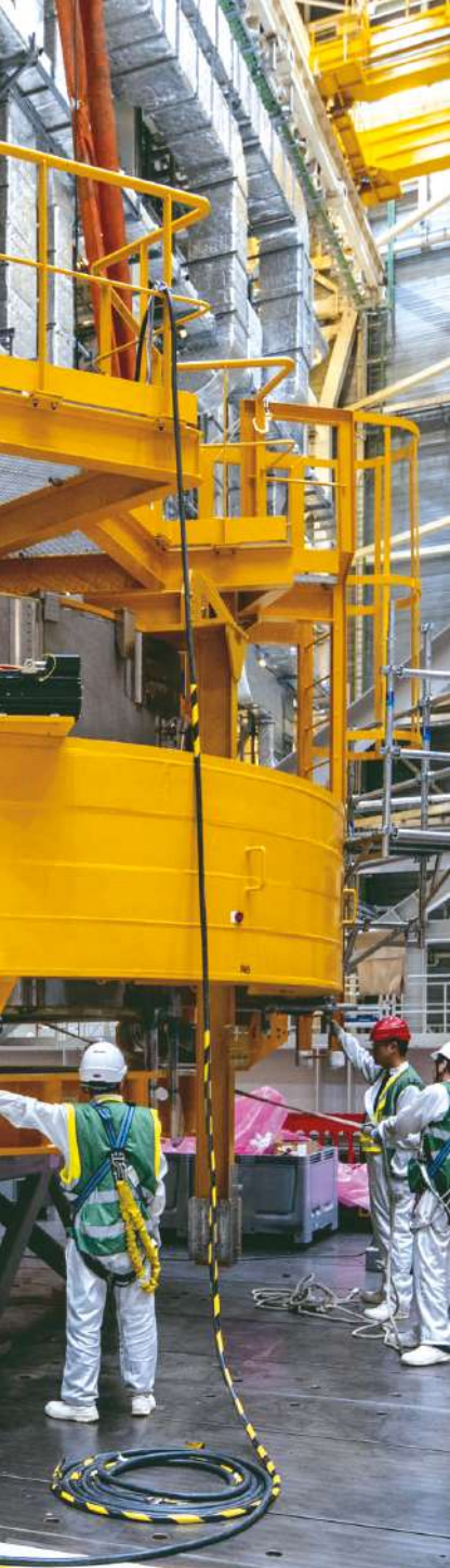
▲ Opération de levage d'un module du solénoïde central.
