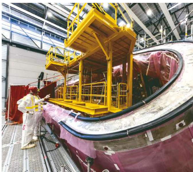
▲ Les réparations de deux secteurs ont eu lieu dans les outils verticaux du hall d'assemblage alors que le secteur n°8 est réparé dans l'ancien atelier cryostat dans une position horizontale.
