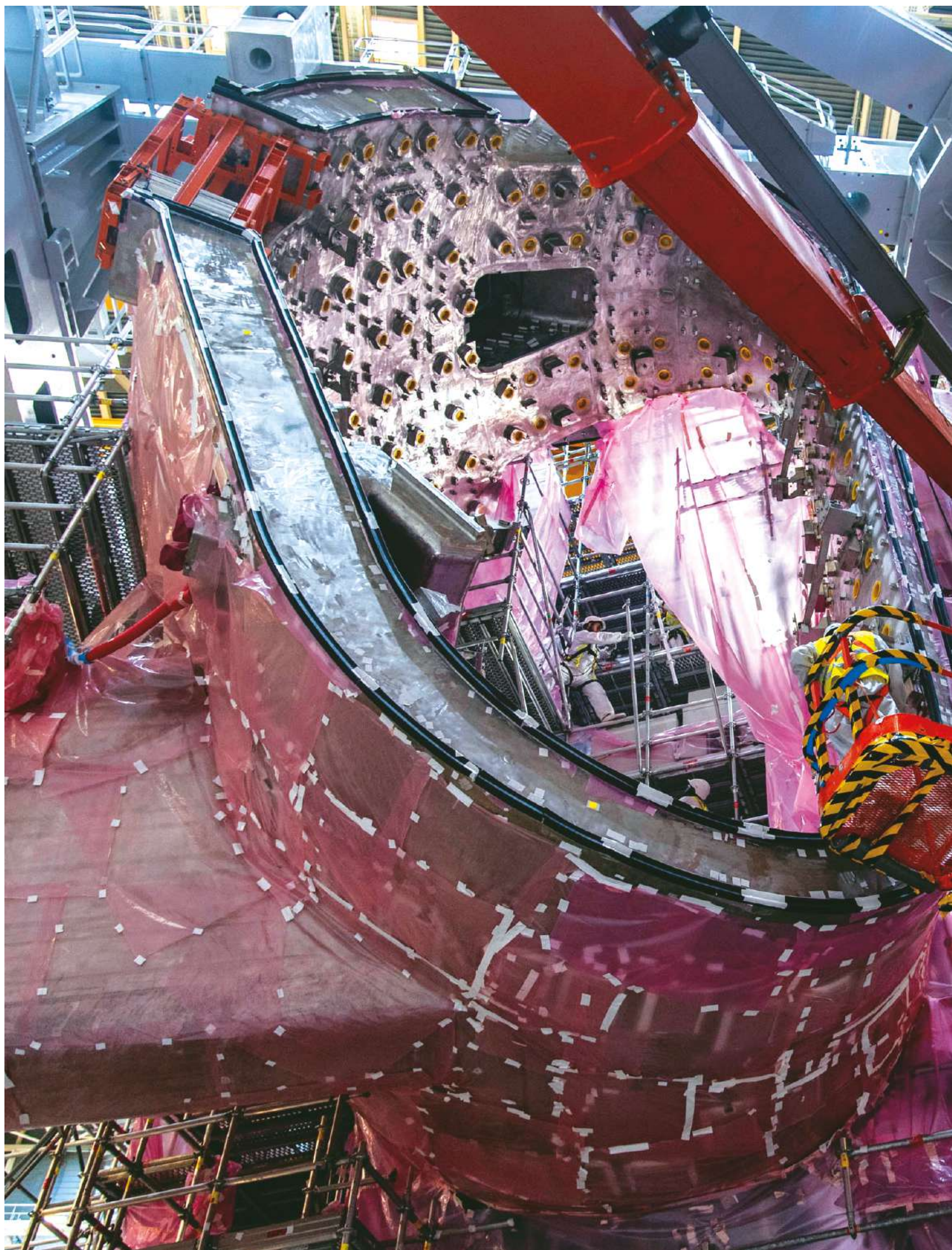
▲ Le secteur n°6 de la chambre à vide, extrait du puits d'assemblage du tokamak au mois de juillet 2023, en cours de réparation.
