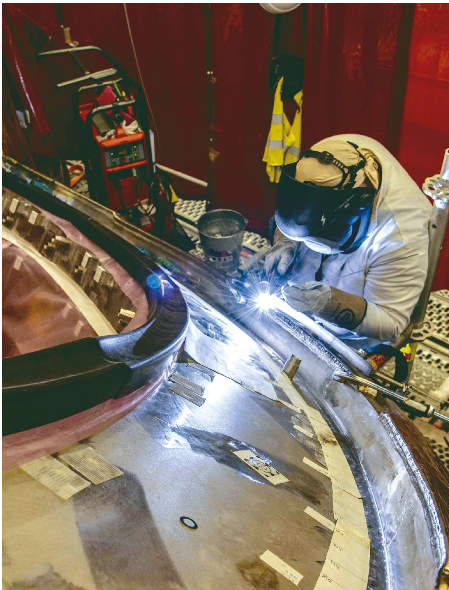
▲ Le processus de dépôt de métal pour le secteur 8 est en grande partie automatisé, vu les quantités de dépôt de métal nécessaires.
