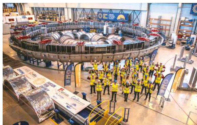
▲ Le 16 avril 2024, les équipes de Fusion for Energy, ITER Organization, APAVE, ASG, S&I, MAMMOET et CNIM fêtent la fin des activités de production sur la bobine de champ poloidal PF3.
