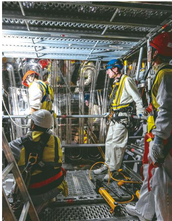
▲ Les opérations d'assemblage du module de secteur 7 ont commencé au mois de septembre 2024.
