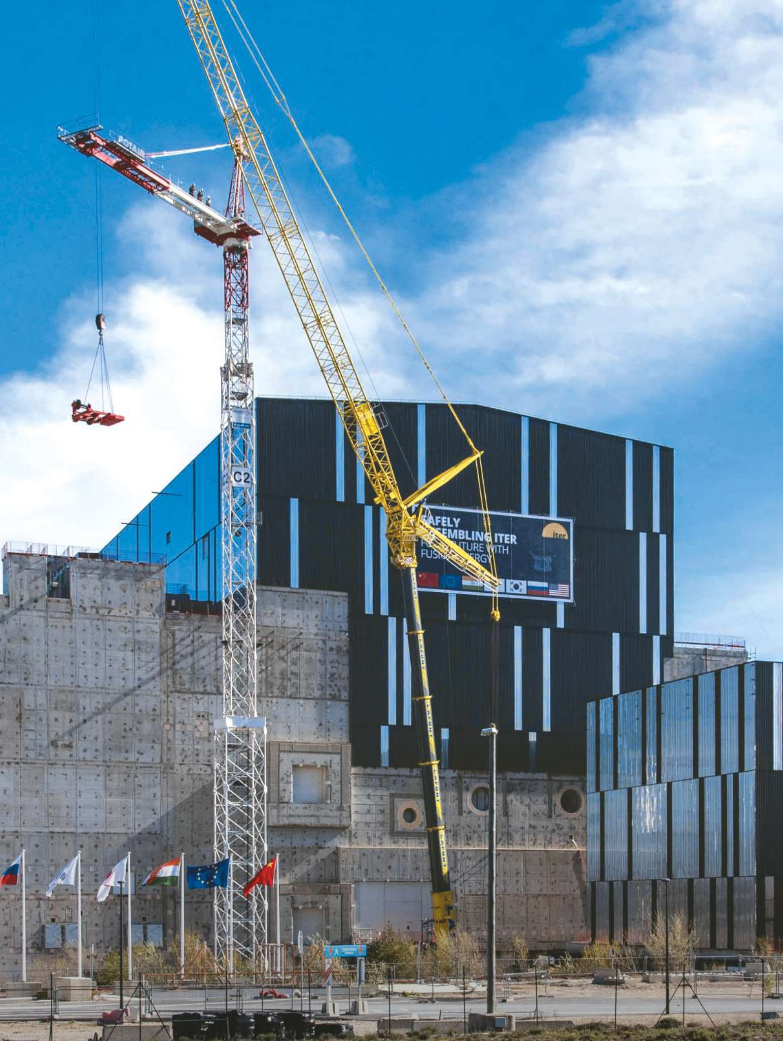
Vue sur le Complexe tokamak.
