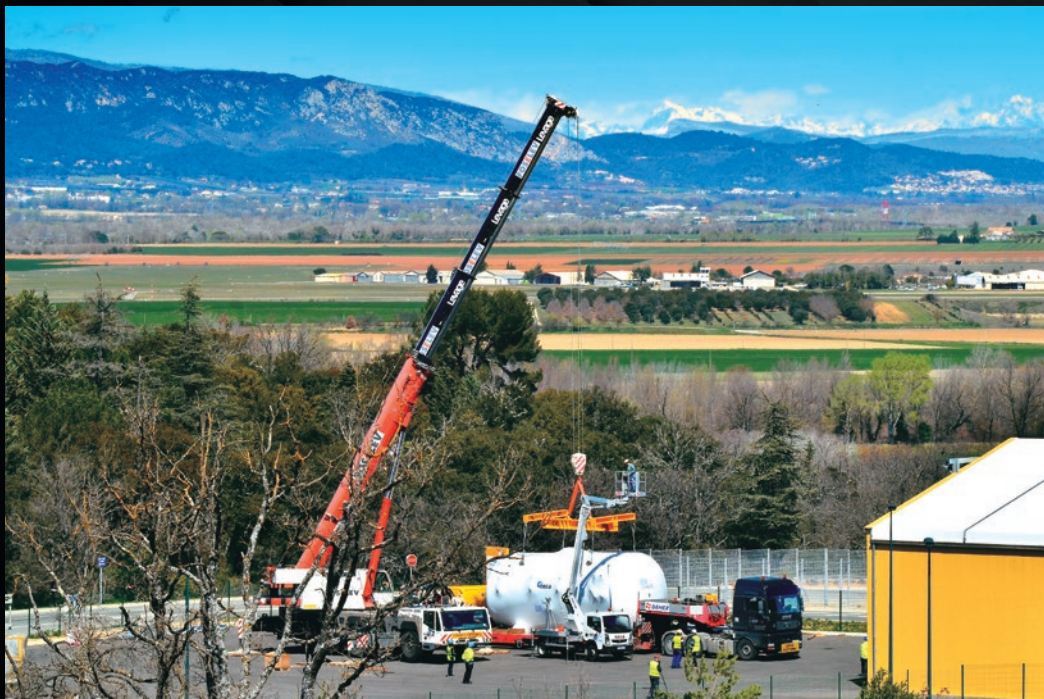
Au printemps 2015, deux cuves de 100 m 3 destinées au système de traitement du tritium sont livrées sur site. Fournies par l'Europe, elles ont été fabriquées en Espagne.
