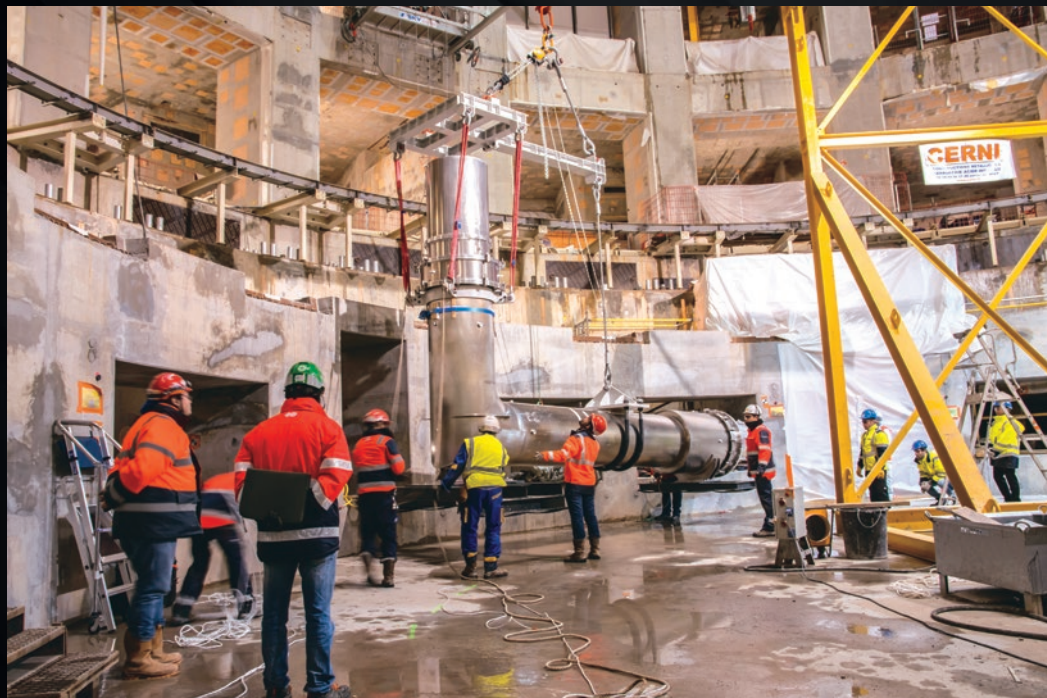
Fournie par la Chine, cette pièce massive (6,6 tonnes et 10 mètres de long) est un élément du système d'alimentation des aimants. Ce magnet feeder est le premier composant à être installé dans le puits d'assemblage du tokamak.
