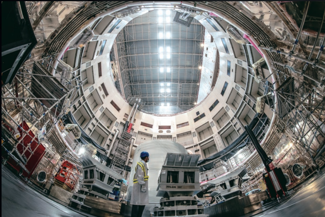
La phase d'assemblage du cœur de la machine a été lancée au mois de mai 2020. La base du cryostat et le cylindre inférieur, la partie basse de l'écran thermique, les piédestaux des bobines verticales ainsi que les supports temporaires destinés à la bobine annulaire PF6 sont en place.
