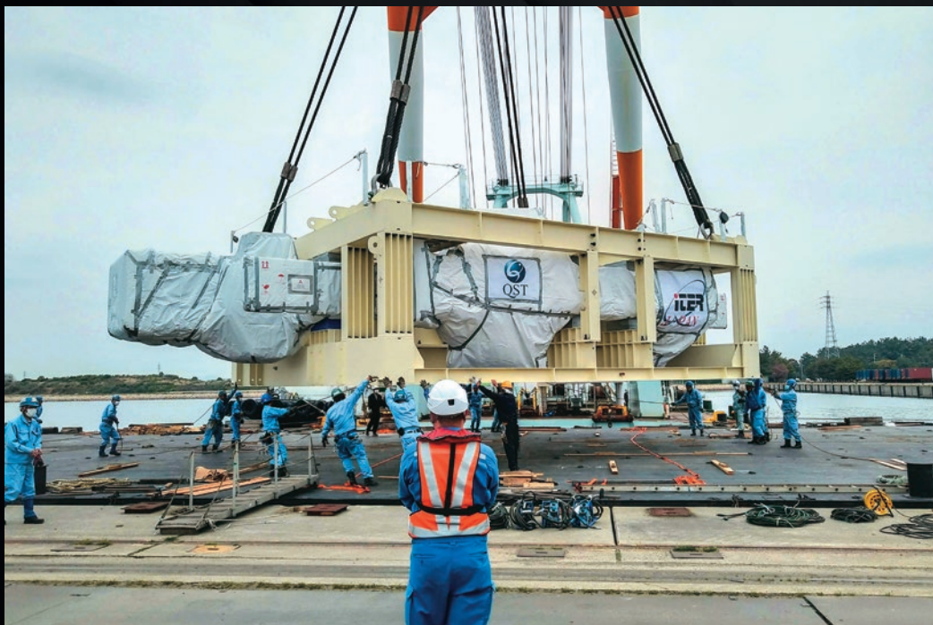
Dans le port de Kobe, au Japon, une bobine de champ toroidal soigneusement « emballée » et arrimée à son cadre de transport, s'apprête à entreprendre le long voyage vers le sud de la France.
