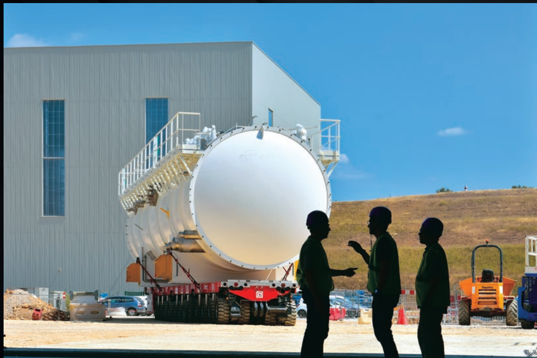
Fabriquée dans la région de Grenoble par la société Air Liquide, cette « boîte froide » est destinée à l'installation hélium liquide de l'usine cryogénique. Deux équipements similaires seront livrés et installés au cours de l'année.
