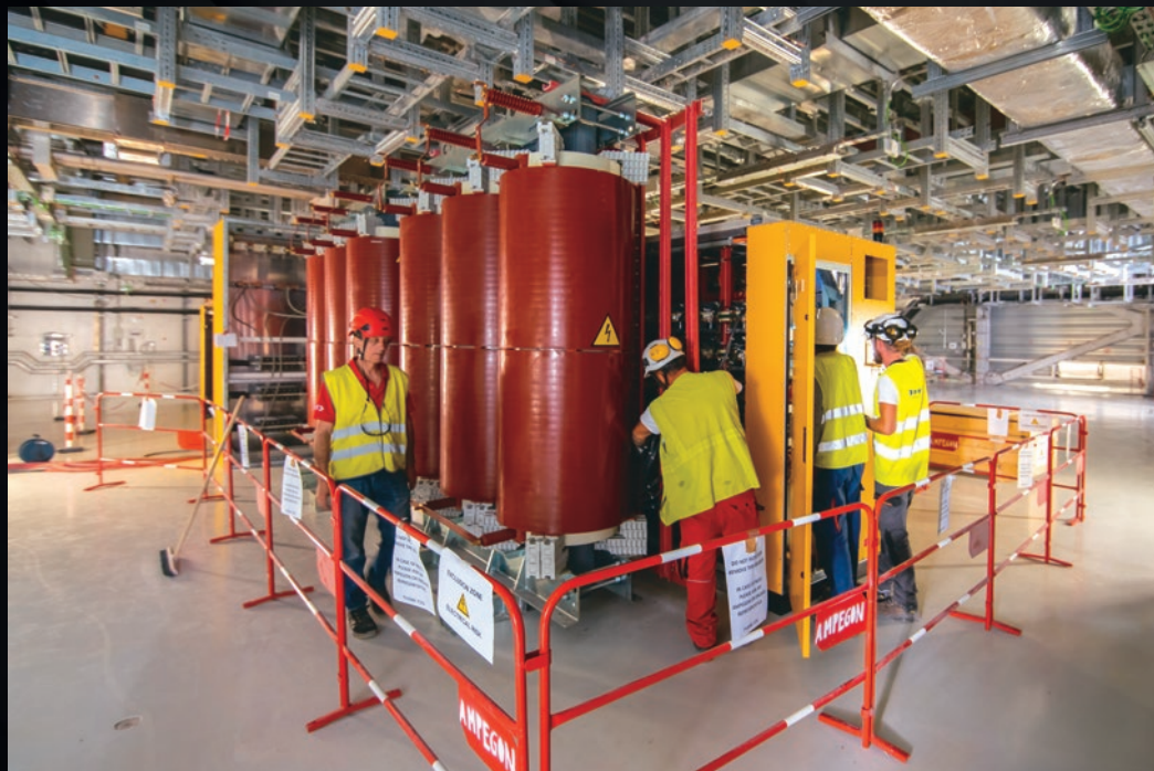
Destinée au système de chauffage du plasma par résonance électronique-cyclotronique, une alimentation électrique haute tension est en cours d'installation dans le Bâtiment radiofréquence.
