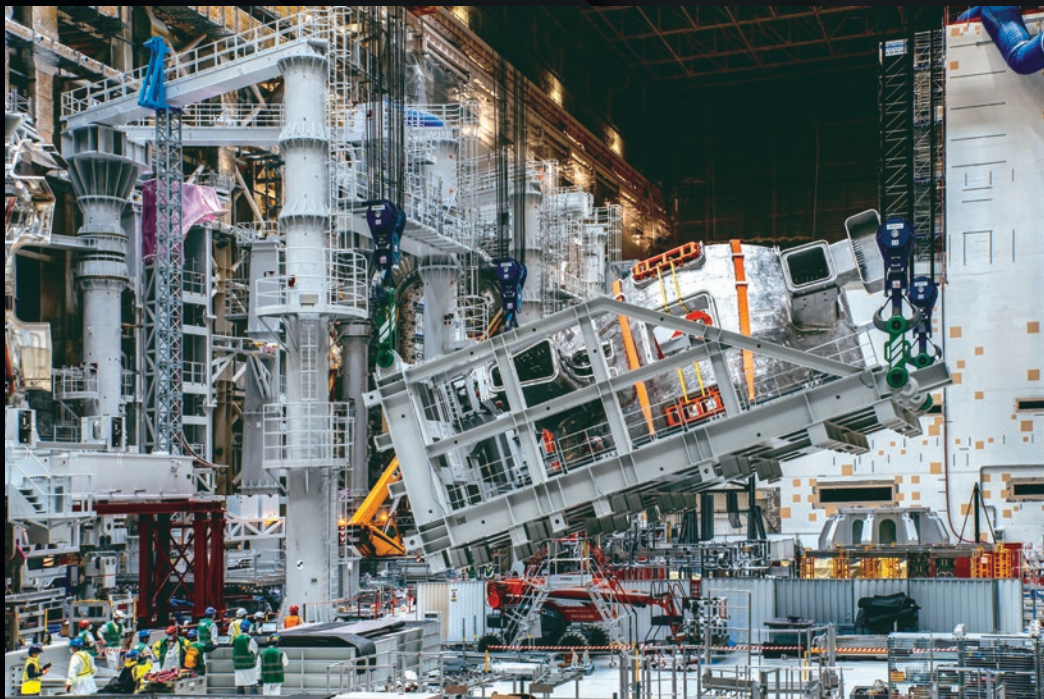
Au cours des opérations de pré-assemblage, ce "berceau de basculement" est utilisé pour faire passer les éléments les plus lourds, comme ce secteur de chambre à vide de 440 tonnes, de la position horizontale à la position verticale.
