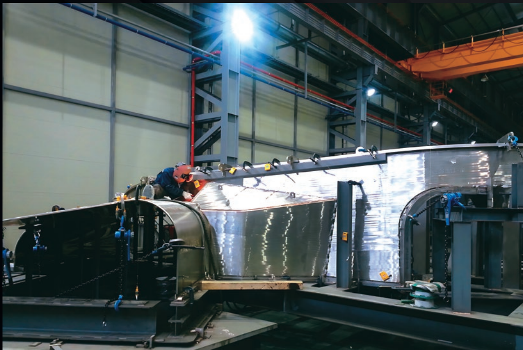
Activement refroidi et recouvert d'une mince couche d'argent, l'écran thermique protégera les aimants des transferts de chaleur radiatifs. Chez SFA Engineering, en Corée, les opérations de soudage d'un premier panneau sont en cours.
