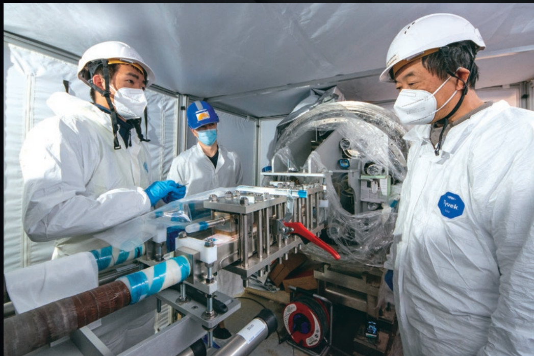
Dans les profondeurs du Bâtiment tokamak, des spécialistes mettent en place un premier joint supraconducteur sur une ligne d'alimentation ( feeder ) haute tension. L'opération est particulièrement délicate et devra être reproduite plus de 300 fois.
