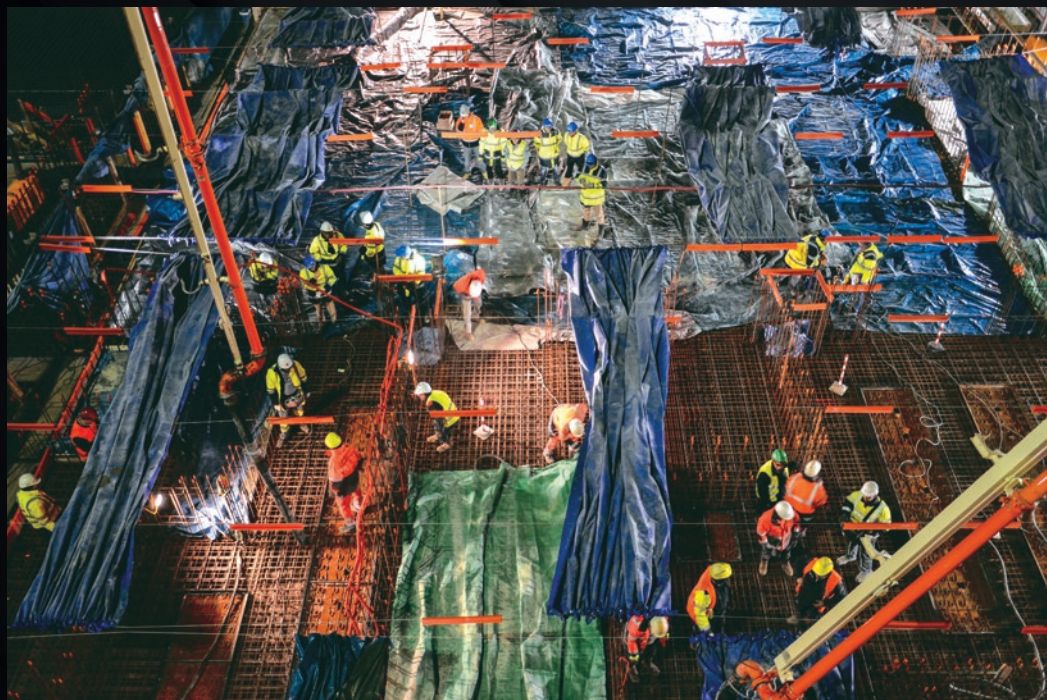
Le 11 décembre 2013, le coulage du béton de la dalle sur laquelle reposeront les 400 000 tonnes du Complexe tokamak commence peu avant l'aube. Le Complexe tokamak est un ensemble constitué du Bâtiment tokamak, qui abritera la machine, du Bâtiment tritium et du Bâtiment diagnostics.
