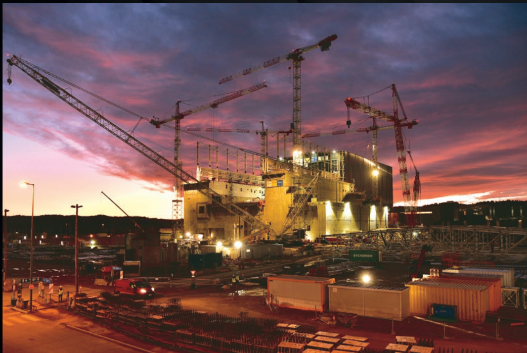
Aux premières lueurs de l'aube, le 4 décembre, une puissante grue sur chenille s'apprête à lever le premier des cinq modules de la charpente métallique du Bâtiment tokamak.
