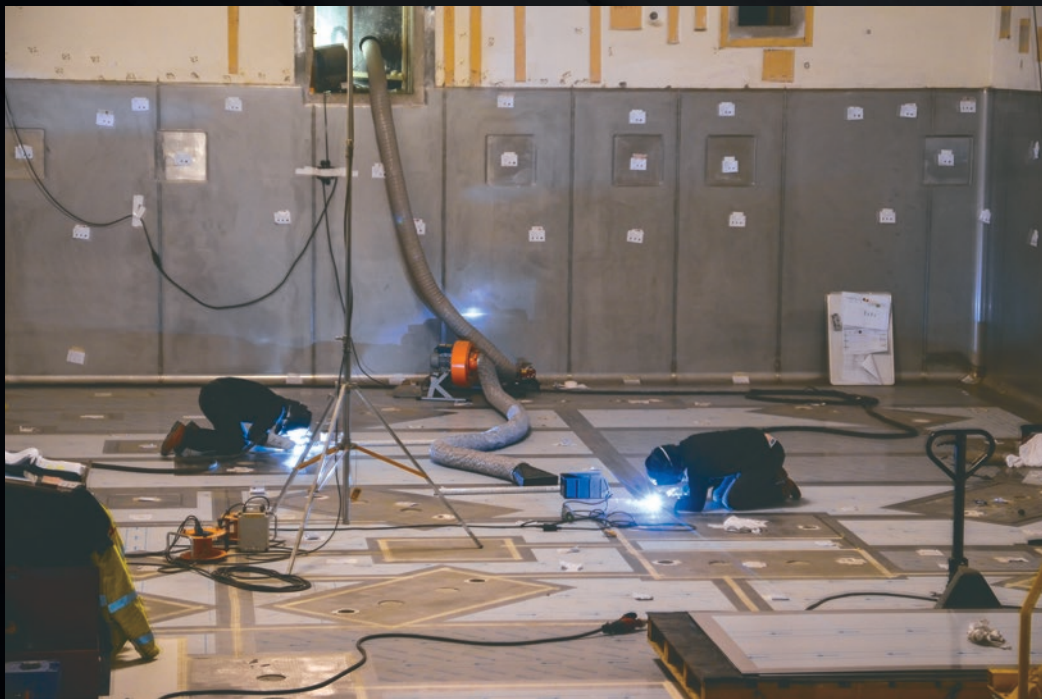
Dans les profondeurs du Bâtiment tokamak, on pose des plaques d'acier sur le sol et au bas des murs de la salle qui accueillera les cuves de drainage. En cas de fuite dans le circuit de refroidissement, cet espace doit être parfaitement étanche de manière à contenir les effluents contaminés.
