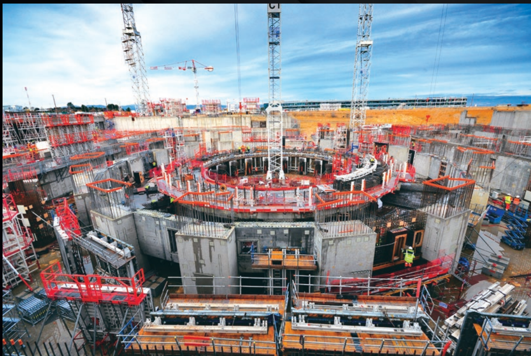
D'une épaisseur de 3 mètres, le bouclier de protection biologique (bioshield) en cours de construction (au centre) isole l'environnement des radiations générées par les réactions de fusion au cœur du tokamak.
