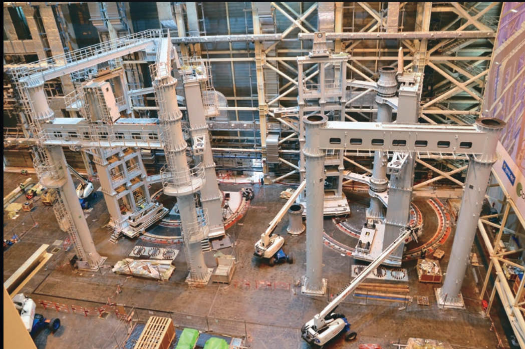
Un second portique de pré-assemblage en tout point identique au premier (22 mètres de haut, 800 tonnes) vient d'être livré par la Corée.
