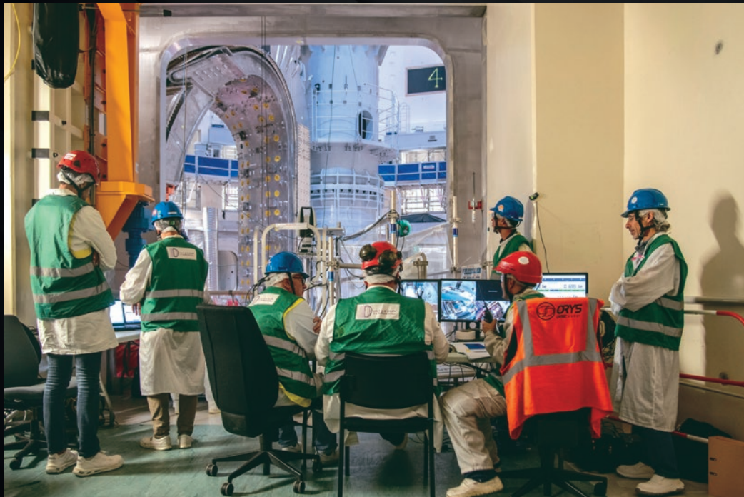
Les mêmes équipes qui, au mois de mai 2022, avaient procédé à l'installation du module n° 6 sont mobilisées pour extraire cette pièce de 1 350 tonnes du puits d'assemblage.
