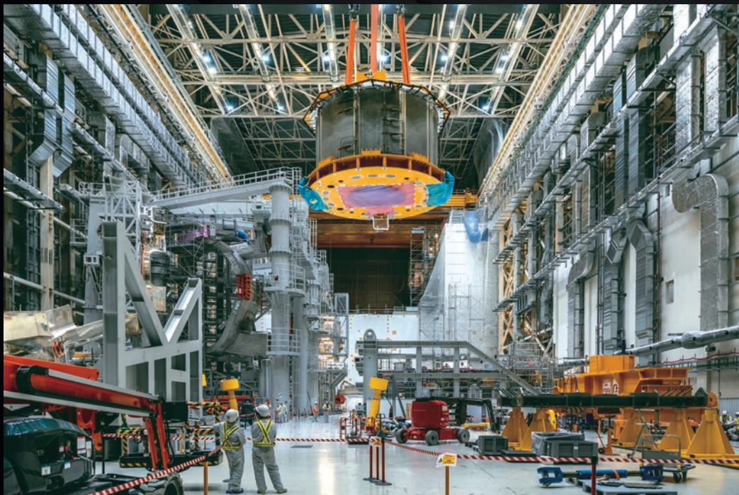
Arrivé des États-Unis au mois de septembre 2021, le premier des six modules du solénoïde central (un aimant d'une masse totale de 1 000 tonnes) est transféré dans le Hall d'assemblage.
