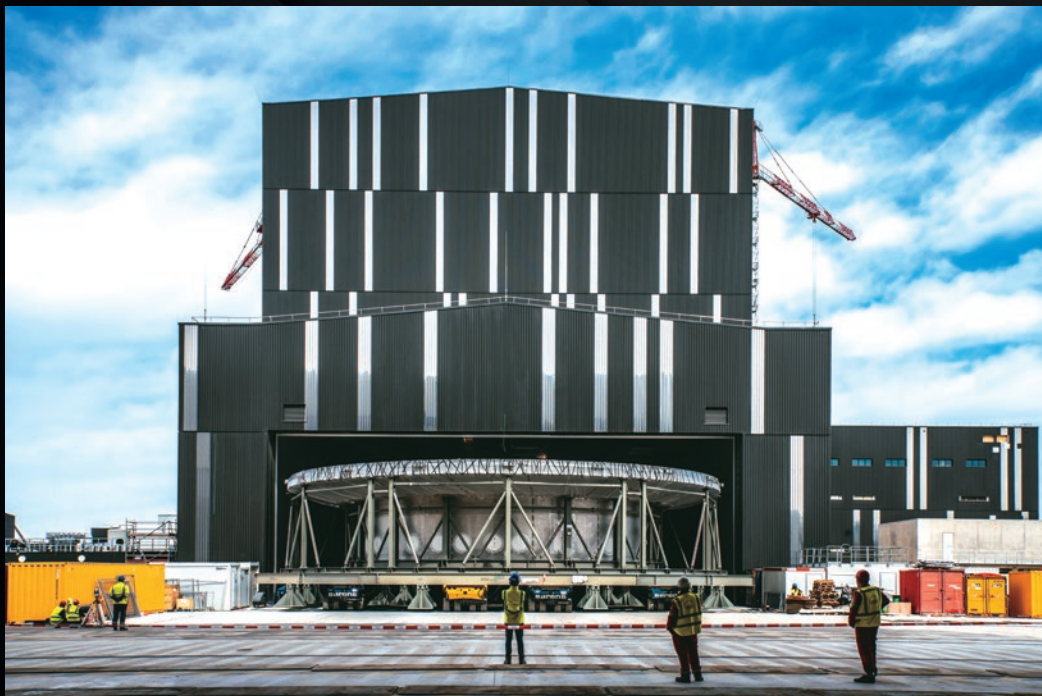
La large porte de l'espace de nettoyage, antichambre du Hall d'assemblage, vient de s'ouvrir pour laisser passage à la base du cryostat – la plus lourde (1 250 tonnes) de toutes les pièces de la machine et la première dans la séquence d'assemblage.
