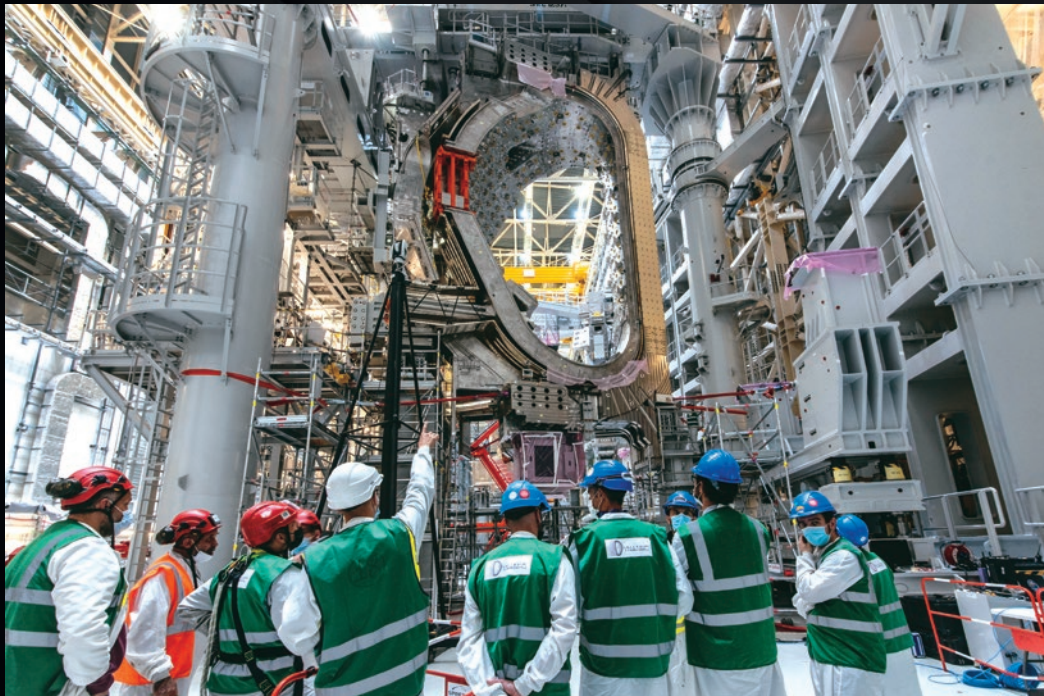
Préalablement à son installation imminente dans le puits du tokamak, le module de chambre à vide n° 6, d'un poids de 1 380 tonnes, est soulevé de 50 centimètres puis reposé sur ses supports. Il s'agit de vérifier les systèmes de levage, la succession des séquences et la coordination des équipes.
