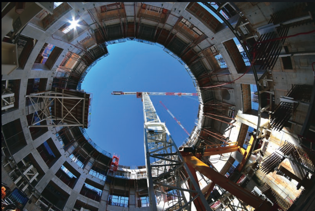
Le puits d'assemblage du tokamak, un espace cylindrique de 30 mètres de diamètre et 30 mètres de hauteur, est en cours de construction.
