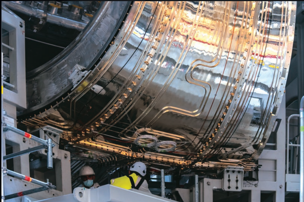
Une fois positionné dans le portique de pré-assemblage, le secteur de chambre à vide est associé à un écran thermique recouvert d'une fine couche d'argent (visible sur cette photo) et à deux bobines verticales. L'ensemble forme un module, prêt à être transféré dans le puits d'assemblage.
