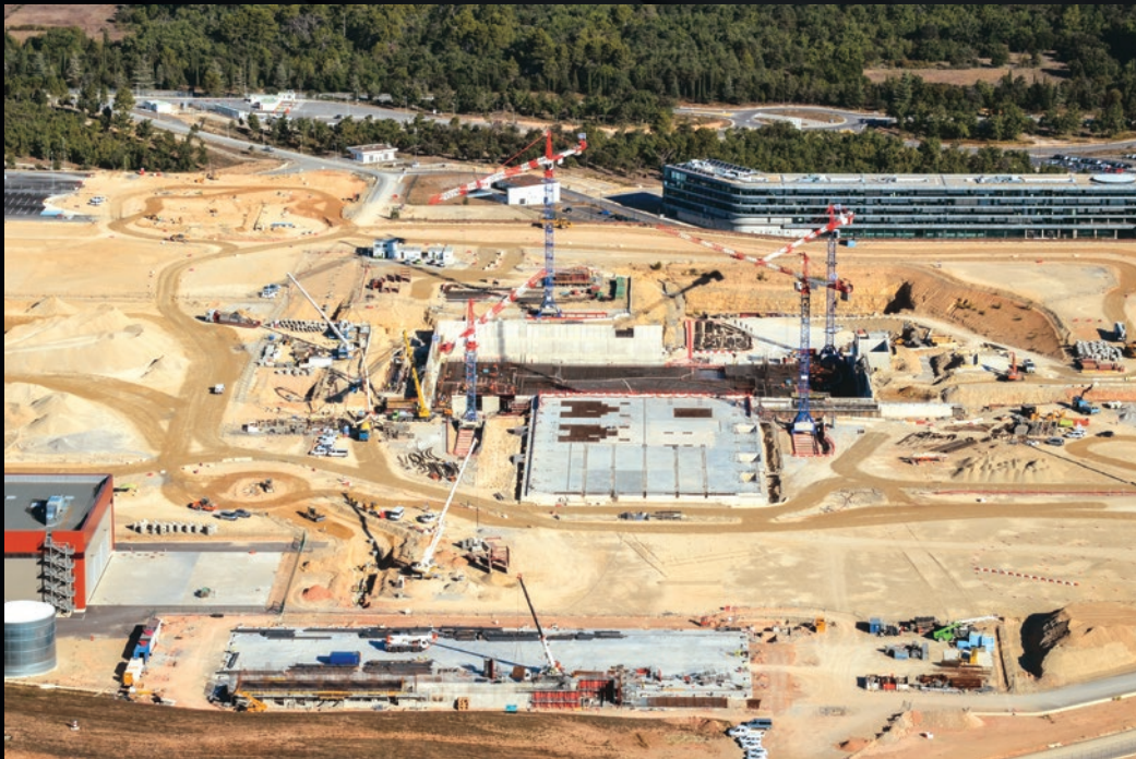
Une vue aérienne partielle de la plateforme ITER au mois de septembre 2013 : au premier plan, la dalle encore nue de l'Atelier du Cryostat ; en bas à gauche, l'extrémité de l'usine de bobinage des aimants de champ poloidal (annulaires) ; au centre le radier du Hall d'assemblage et, en contrebas, les fondations du Complexe tokamak ; à l'arrière plan, le siège d'ITER Organization qui, à cette date, accueille déjà quelque 500 personnes.
