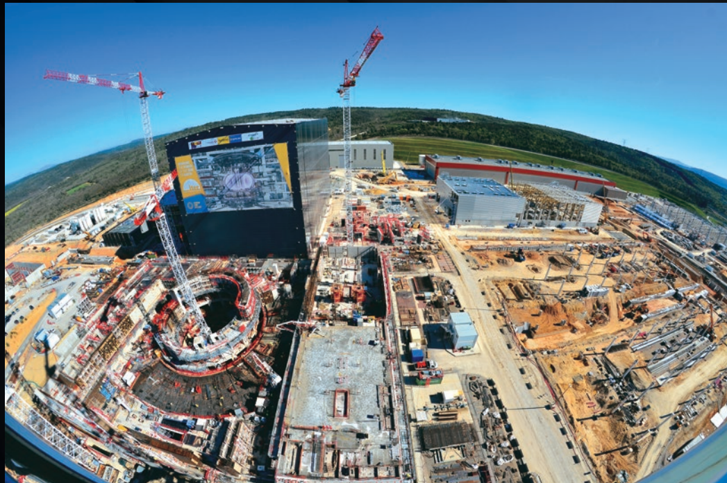
La quasi-totalité de la plateforme ITER se révèle dans cette image prise depuis l'une des plus hautes grues du chantier. La structure rectangulaire en cours de construction, au centre, est le Bâtiment diagnostics. Un éclaté du tokamak (70% de la taille réelle) orne la façade temporaire du Hall d'assemblage.
