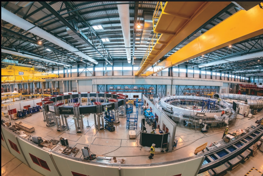
Deux bobines de champ poloidal de 17 mètres de diamètre, ainsi qu'une enceinte sous vide destinée aux tests à très basse température (à droite), sont visibles sur cette image.
