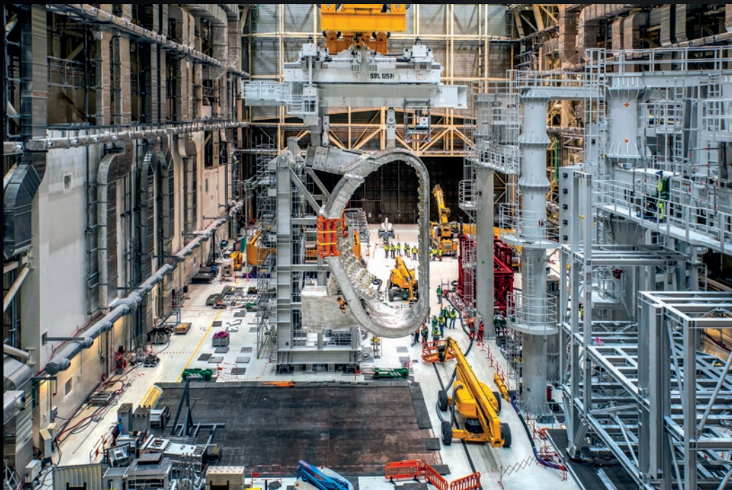
Entre les crochets du double pont roulant et les 440 tonnes du secteur de chambre à vide, un système de levage complexe s'interpose, qui permet de contrôler le positionnement de la charge et de piloter sa rotation.
