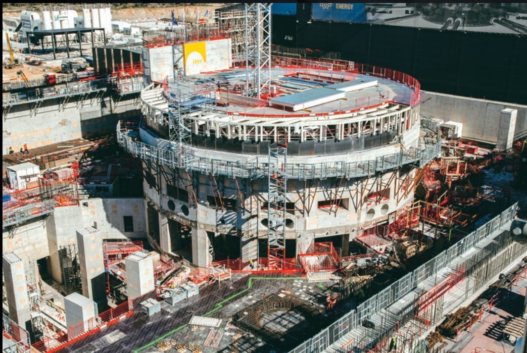
Le « couvercle » qui ferme désormais le bouclier de protection biologique ( bioshield ) permet aux équipes de travailler en toute sécurité dans les niveaux inférieurs du puits d'assemblage du tokamak.
