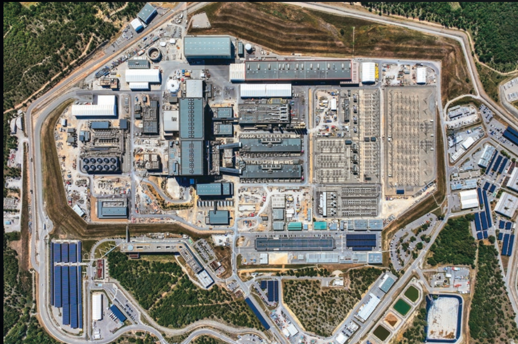
Le site d'ITER au mois de juin 2024. La quasi-totalité de l'infrastructure technique et industrielle est désormais en place.
