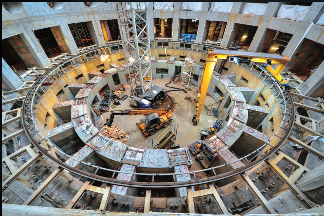
Tout au fond du puits d'assemblage du tokamak, le coulage du béton de la « couronne » se poursuit.
