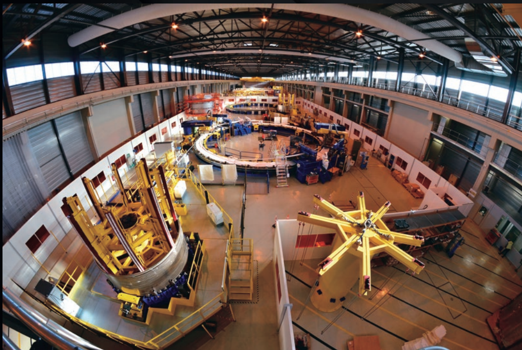
Sur site, dans sa vaste usine de bobinage, l'Europe vient de lancer la fabrication de la bobine de champ poloidal n° 5 d'un diamètre de 15 mètres et d'un poids de 340 tonnes.
