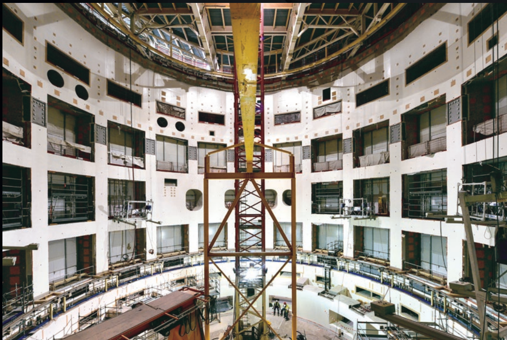
Le tokamak, enveloppé de son cryostat, sera assemblé dans ce volume de 25 000 m 3 aux allures d'amphithéâtre. Les parois de béton brut sont désormais recouvertes de plusieurs couches de peinture spéciale.
