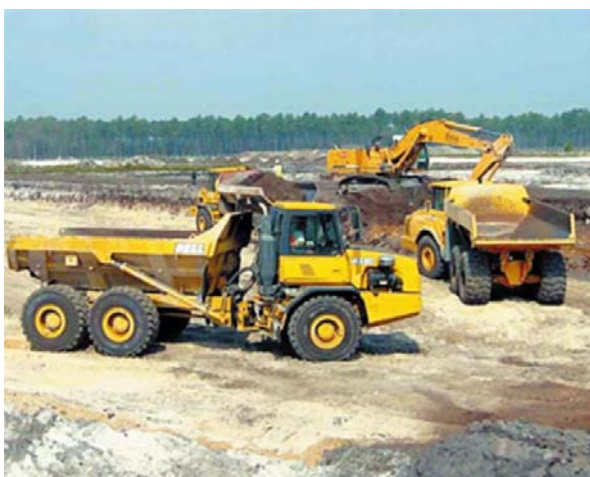
Figure 18 : illustration du chantier
