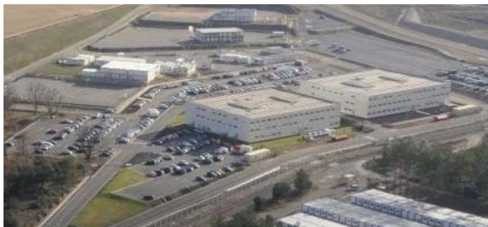
Bâtiments des bureaux provisoires (JWS2 et 3)
