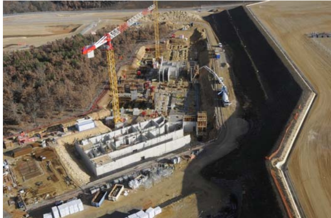
Construction du Siège en décembre 2010
