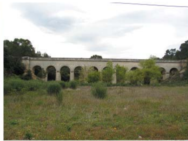
Aqueduc de Valbonnette
