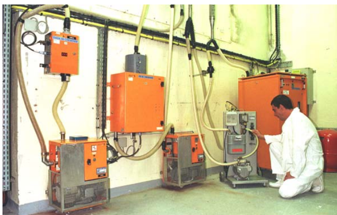
Figure 8 : intervention d'un agent de radioprotection.
