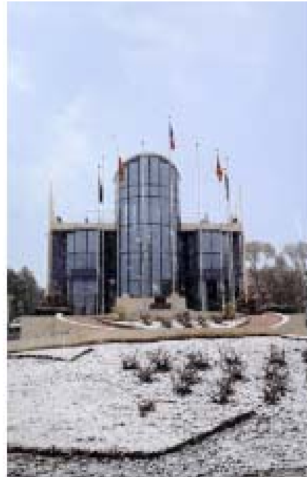
Figure 5 : bâtiment d'accueil du Centre de Cadarache sous la neige
