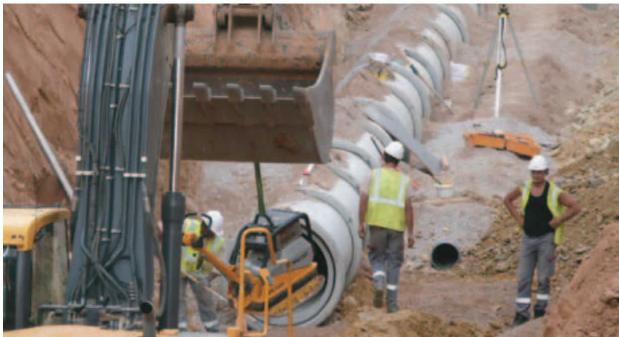
Personnel sur le chantier des travaux d'aménagement du réseau hydrauliques
