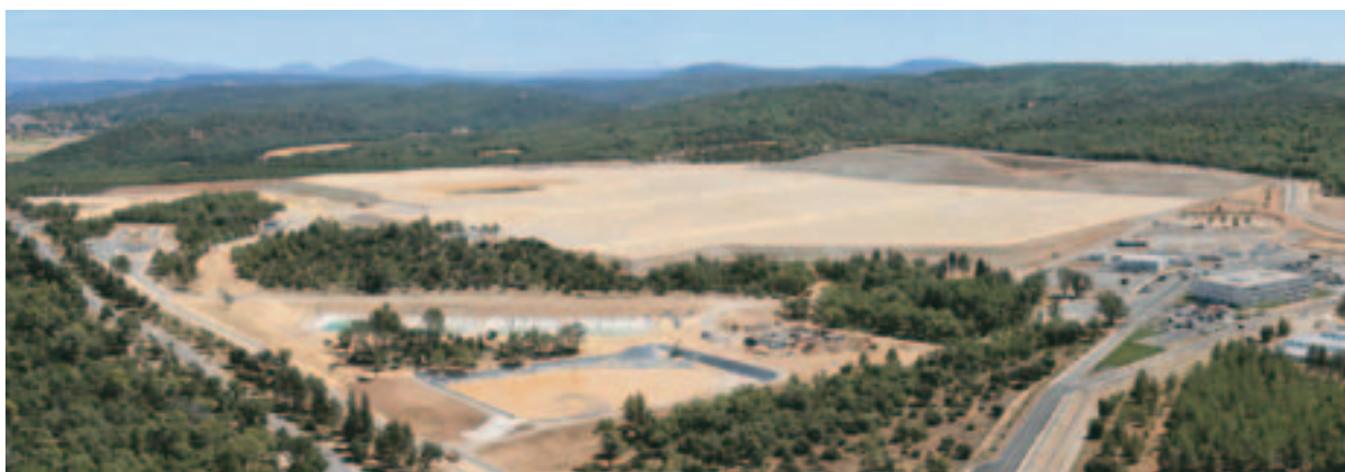
Travaux de terrassement sur le site, avec au premier plan, le bassin d'orage. Ce bassin d'une capacité de 19 000 m 3 est dimensionné pour une pluie décennale (débit de fuite de 0,6 m 3 /s) évacuée via une canalisation d'un diamètre de 800 mm. Une déverse permet d'assurer l'évacuation d'une pluie centennale.
