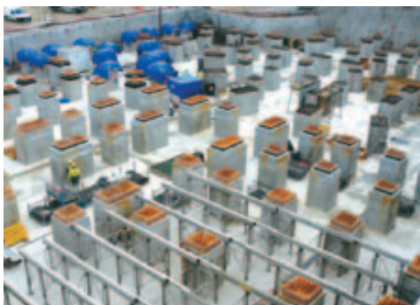
Patins parasismiques du réacteur Jules Horowitz au CEA Cadarache
