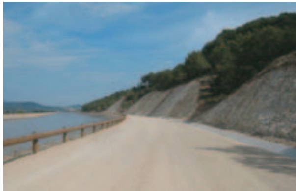
Aménagement de la route le long du canal à La-Roque-Anthéron
