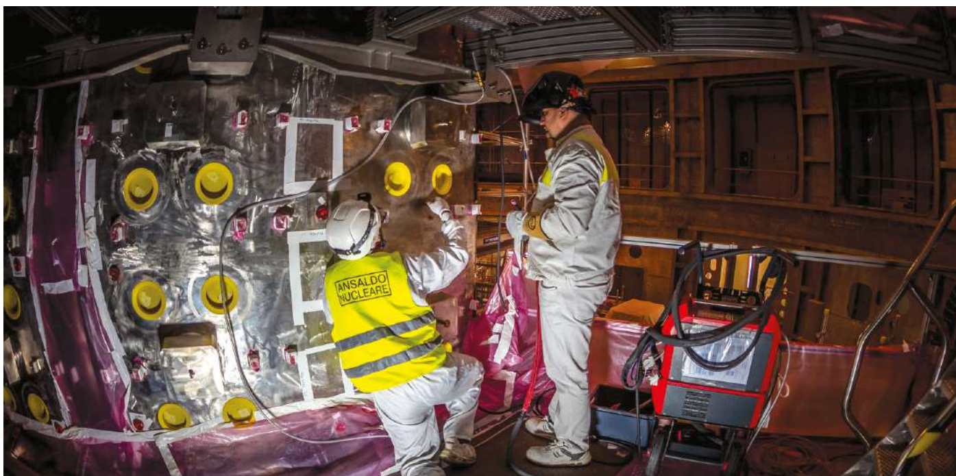
▲ Les équipes travaillent sur la surface intérieure des secteurs de la chambre à vide dans le puits. Des plateformes à trois niveaux leur permettent d'accéder à tous les recoins.
