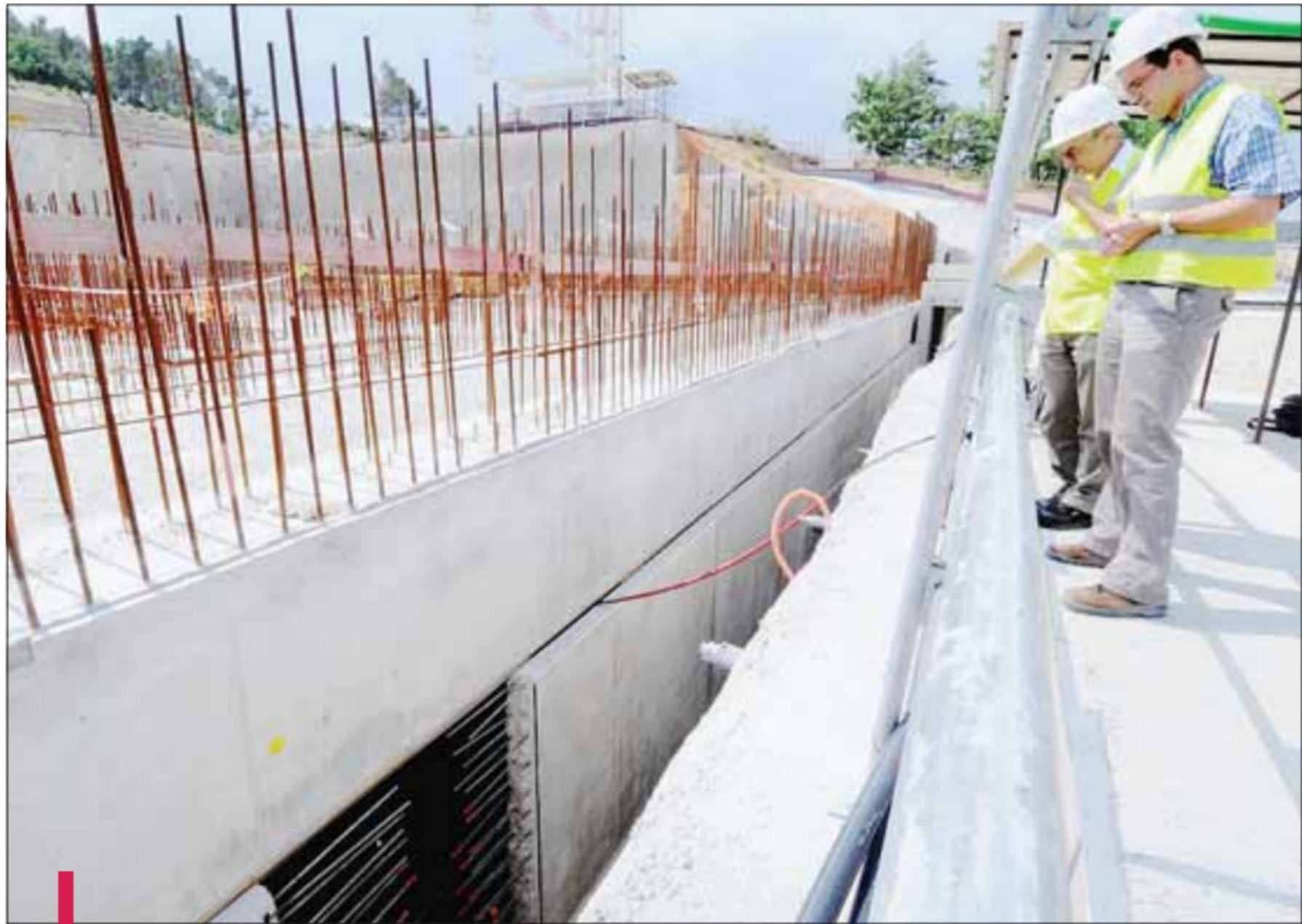
Au CEA, le chantier du réacteur Jules Horowitz continue dans la sérénité : 195 plots antisismiques ont été installés sous cette chape de béton à l'armature spécifique, épaisse d'1m50. / PHOTO SOPHIE SPITÉRI
