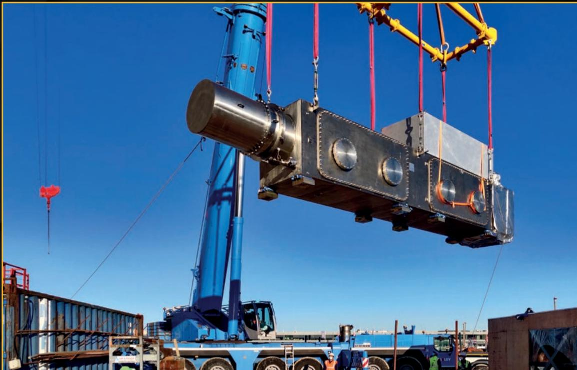
Fabriqués en Chine, les « feeders », ou lignes d'alimentation, fournissent aux aimants la puissance électrique et les fluides cryogéniques.
