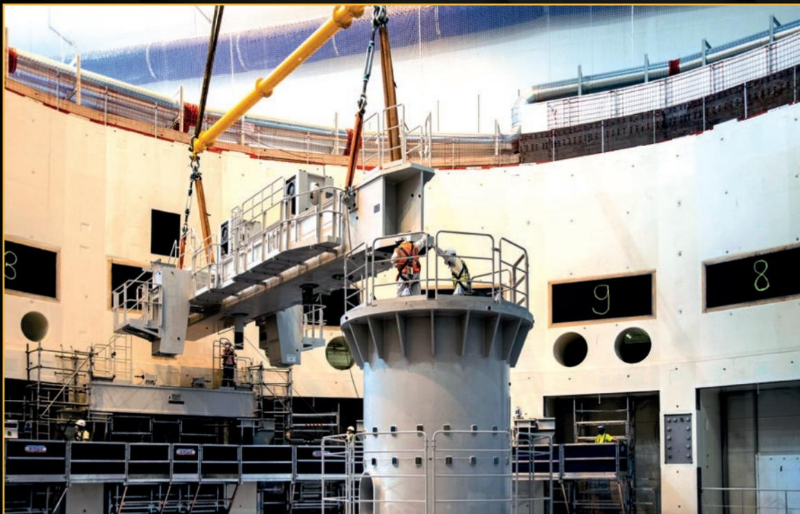
Neuf poutres radiales, amarrées à la paroi interne du puits d'assemblage et à la colonne centrale, soutiendront les modules de chambre à vide pendant la phase de soudage. De la précision de leur positionnement procède celui du cœur de la machine. Ici, un premier test est en cours. **Septembre 2021**
