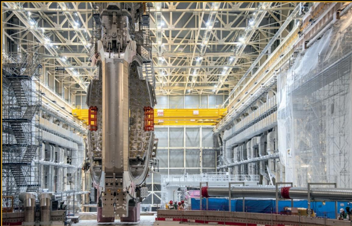
Le 11 mai 2022, le premier des neuf modules qui constituent la chambre à vide du Tokamak a été mis en place dans le puits d'assemblage. Cette opération particulièrement spectaculaire – le module et son système de levage pèsent 1 380 tonnes – a nécessité plusieurs mois de préparation. **Mai 2022**
