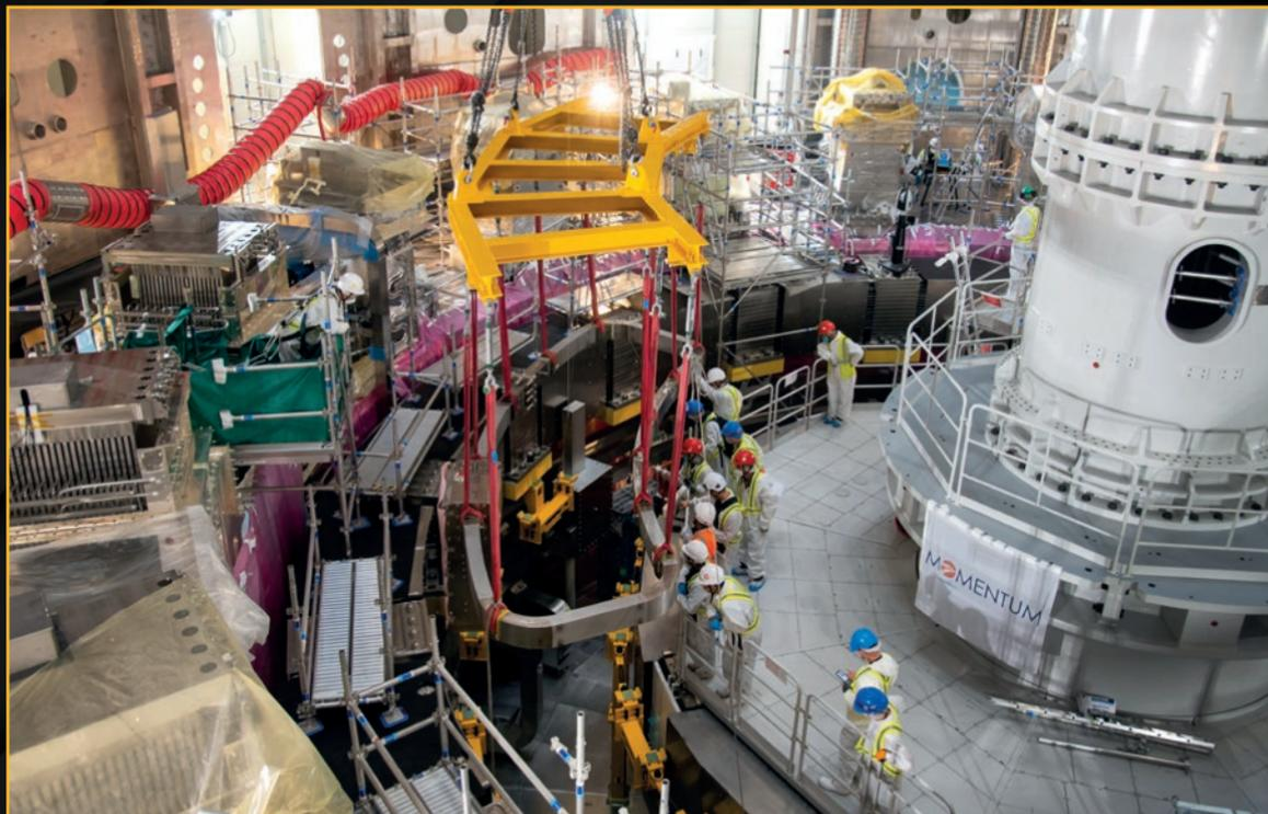
Par leur action, les 18 bobines de correction insérées entre les aimants verticaux et annulaires, permettront d'atténuer les perturbations du champ magnétique et leur incidence sur la stabilité du plasma. À l'automne 2021, six bobines sont d'ores et déjà installées. **Octobre 2021**
