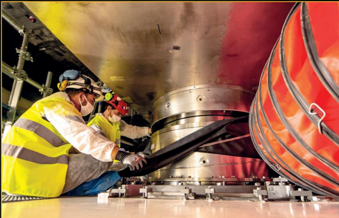
Une fois installés, les éléments et systèmes sont régulièrement inspectés afin de vérifier qu'ils ne se dégradent pas. Ici, deux techniciens s'assurent que les supports du cryostat, dans les profondeurs du puits du Tokamak, ne présentent pas de trace d'humidité. **Septembre 2021**
