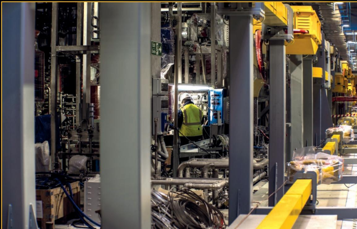
Le courant alternatif fourni par le réseau doit être converti en courant continu, puis « lissé », afin d'alimenter le système magnétique du Tokamak. Dans les deux bâtiments de conversion, près de 80% de l'équipement nécessaire est désormais en place et les premiers tests de mise en service viennent de commencer. **Janvier 2022**
