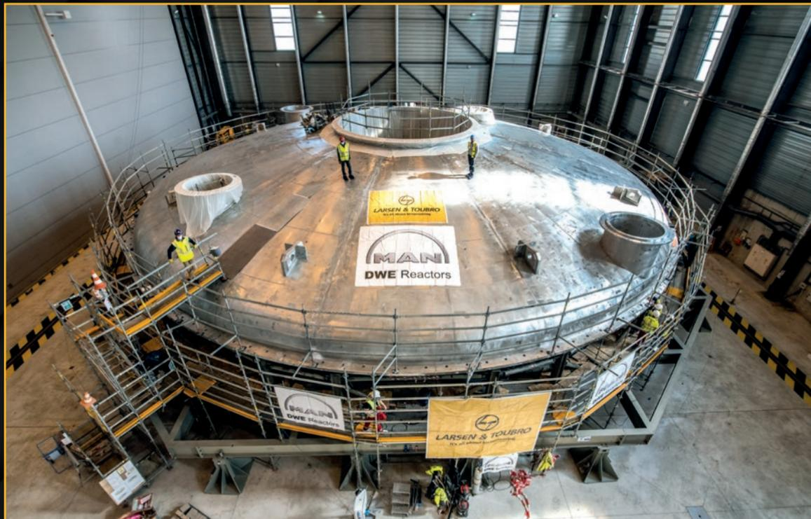
Les quatre sections du cryostat (la base, le cylindre inférieur, le cylindre supérieur et ici le « couvercle ») ont été successivement assemblées et soudées sur site – une aventure industrielle qui aura duré plus de six ans.
