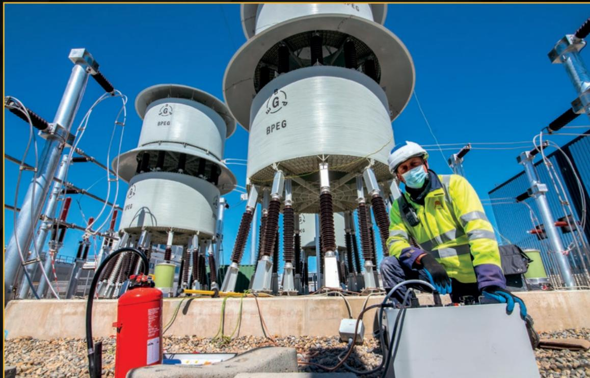
Tandis que se termine l'installation des équipements électriques de compensation de puissance et de filtrage harmonique, fournis par la Chine, un ingénieur procède aux premiers tests de fonctionnalité et de sécurité. **Avril 2021**
