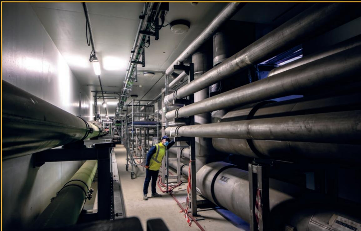
En phase opérationnelle, près de 25 tonnes d'hélium liquide à la température de *moins* 269 °C doivent refroidir le système magnétique supraconducteur du Tokamak. Ce flux circule au travers d'un réseau (*process lines*) long de quatre kilomètres, qui relie le bâtiment Tokamak à l'usine cryogénique.
