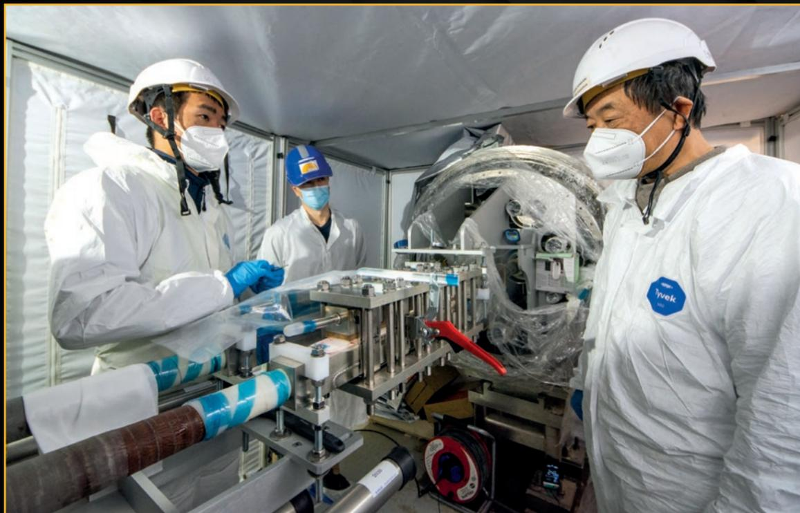
L'assemblage du Tokamak conjugue les opérations spectaculaires, comme l'installation d'éléments hauts comme un immeuble de six étages et aussi lourds que quatre Airbus A380, et les interventions quasi chirurgicales, comme la création de joints supraconducteurs entre deux éléments d'une ligne d'alimentation (photo). **Mars 2022**
