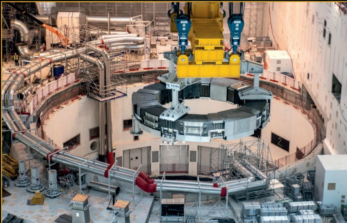
Fournie par l'Europe mais fabriquée en Chine, la bobine de champ poloidal n° 6 (PF6) est la plus lourde (330 tonnes) des bobines annulaires de la machine, et la première à être installée dans le puits du Tokamak. **Avril 2021**
