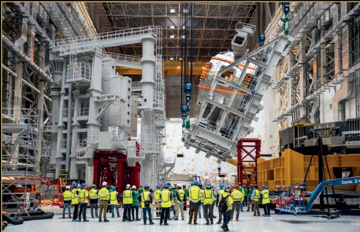
Fourni par la Corée, le premier secteur de chambre à vide passe de l'horizontale à la verticale dans un berceau de basculement pour être positionné dans le portique de pré-assemblage. **Mars 2021**
