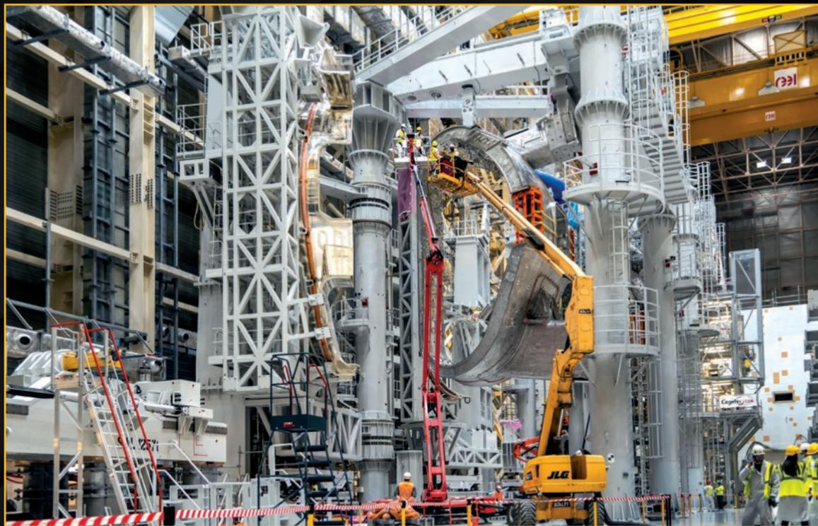
Ces deux portiques géants permettent d'associer un secteur de chambre à vide, deux aimants verticaux et les écrans thermiques correspondants, de manière à former un « module ». Le premier des neuf modules requis a été mis en place au mois de mai 2022, un second est en cours d'assemblage. **Janvier 2022**
