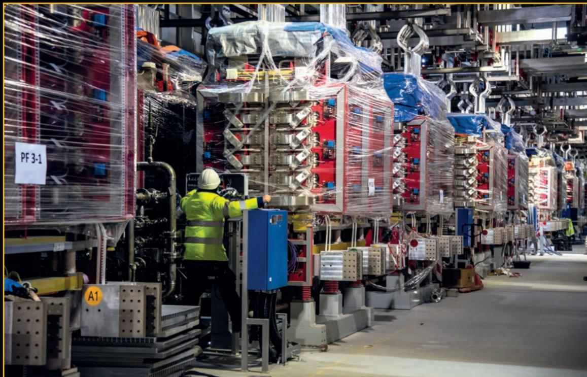
Pour alimenter les six bobines de champ poléoidal de la machine, ces équipements fournis par la Chine convertissent en courant continu le courant alternatif 400 kV du réseau.
