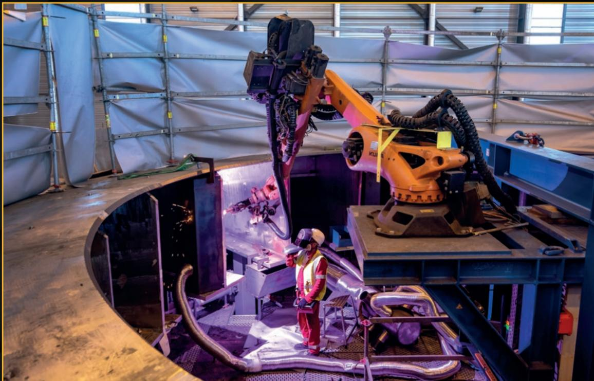
Des quatre sections qui constituent le cryostat, le « couvercle » est la plus épaisse, la plus structurellement complexe et, après la base, la plus lourde (665 tonnes). Comme les autres sections du cryostat, le couvercle est assemblé et soudé sur site par l'Agence domestique indienne et ses sous-traitants avant d'être transféré à ITER Organization. **Septembre 2021**
