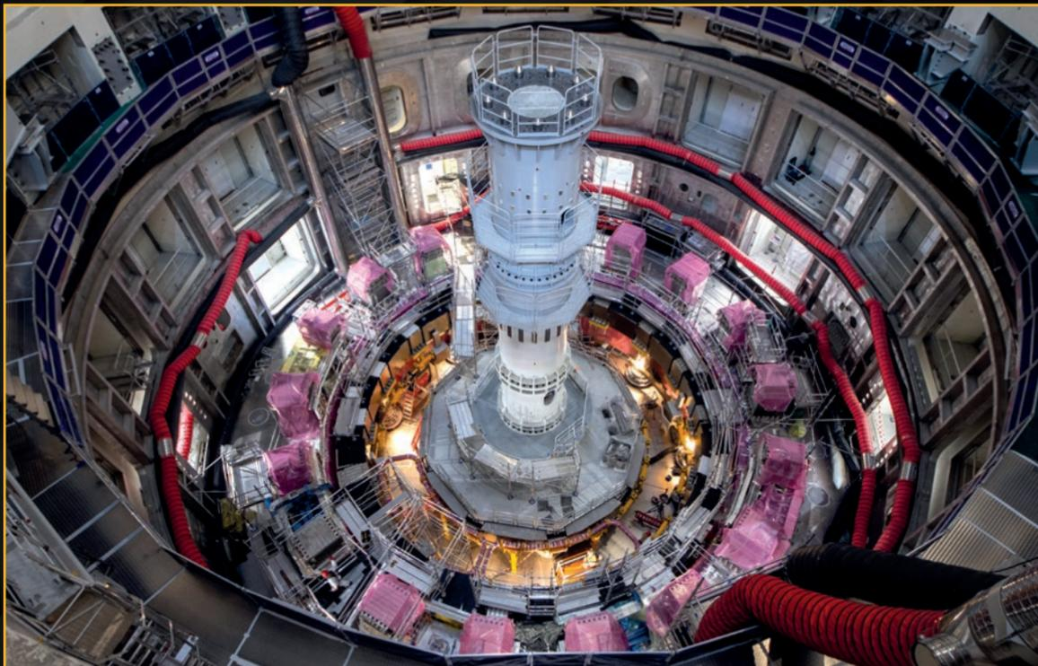
Au cœur du bâtiment Tokamak, dans ce puits de 30 mètres de diamètre et autant de profondeur, la machine prend forme. En 2021, les équipes chargées de l'assemblage ont installé deux aimants annulaires de 10 et 17 mètres de diamètre respectivement, les bobines de correction inférieures, les anneaux de compression de recharge et la colonne centrale. **Décembre 2021**
