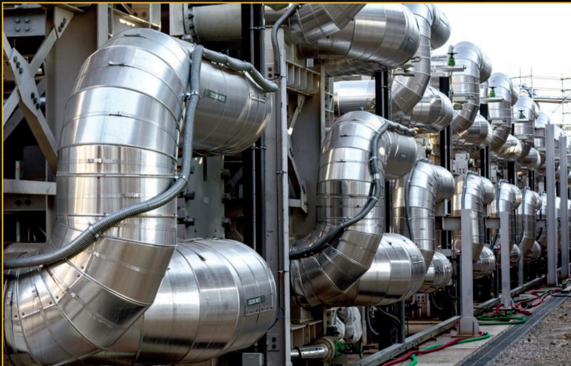
La construction et l'équipement du système de rejet de la chaleur, une installation de 6 000 mètres carrés capable d'évacuer une puissance totale de 1,2 gigawatt, ont été finalisés au mois d'août. Sa mise en service est en cours. **Octobre 2021**
