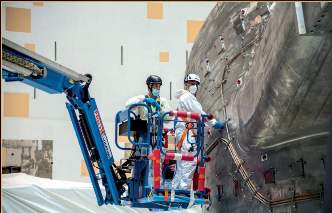
Ce secteur de chambre à vide, encore en position horizontale, est en cours d'équipement (supports pour l'instrumentation et systèmes de diagnostics) dans le Hall d'assemblage. Mars 2021
