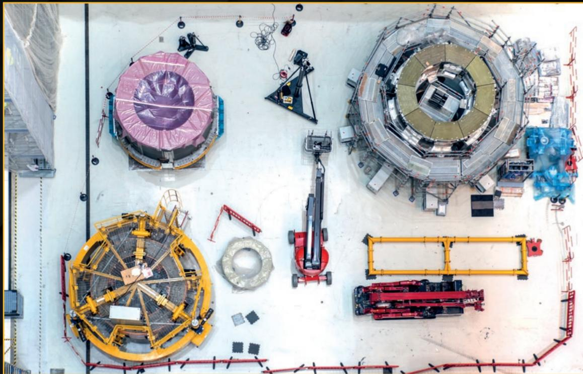
Tous les éléments sont en place pour entamer l'assemblage du solénoïde central, un électro-aimant haut de 18 mètres et pesant plus de 1 000 tonnes : une plateforme dédiée (en haut à droite) ; le premier des six modules du solénoïde (en haut à gauche) et l'outil de levage (jaune) qui permettra de les empiler et de les solidariser. **Avril 2022**
