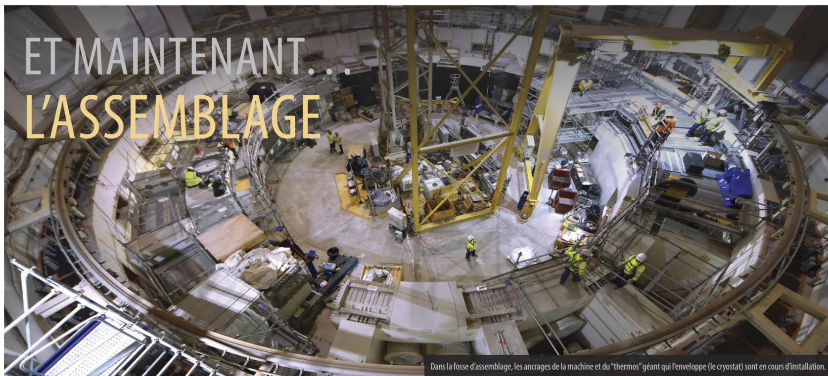
Dans la fosse d'assemblage, les ancrages de la machine et du "thermos" géant qui l'enveloppe (le cryostat) sont en cours d'installation.
