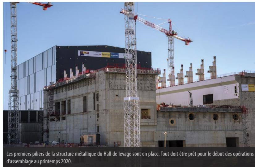
Les premiers piliers de la structure métallique du Hall de levage sont en place. Tout doit être prêt pour le début des opérations d'assemblage au printemps 2020.
